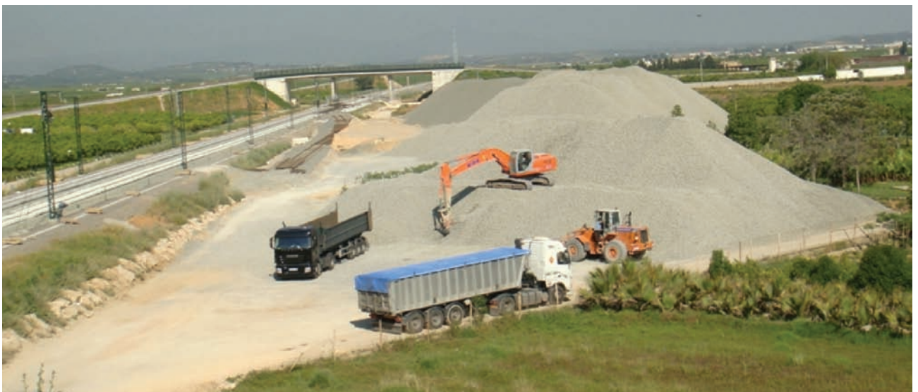
Foto 4. Acopio de balasto en traza
