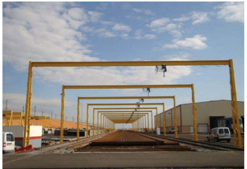
Foto 7. Acopio en base de montaje de carril en barra larga de 270 m.
