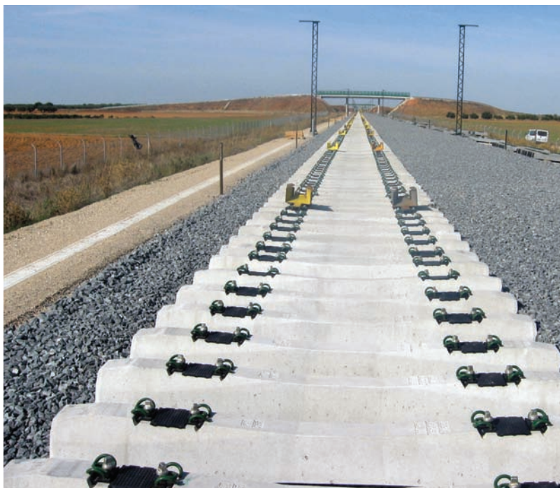
Foto 5. Traviesas monobloque de hormigón Al-04 posicionadas en la traza.
