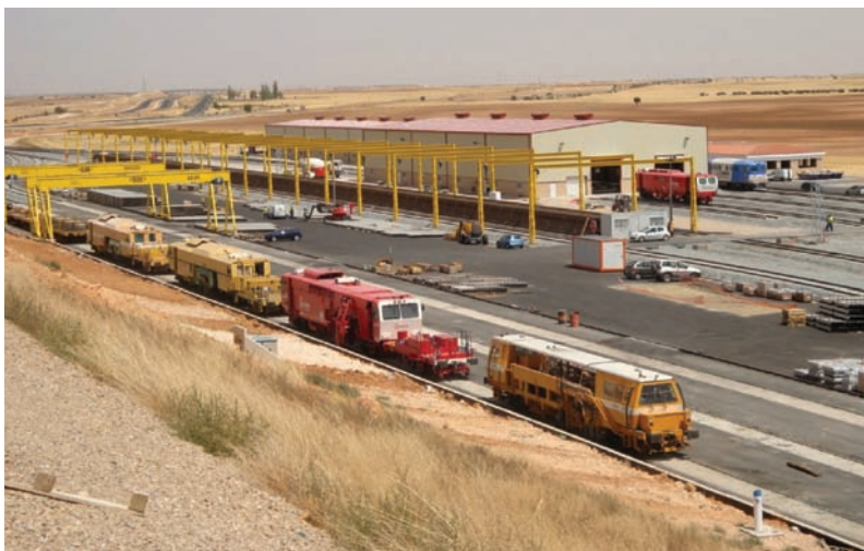
Arriba, foto 1. Base de Montaje de Villarrubia de Santiago. Abajo, foto 2. Base de Montaje de Albacete.
