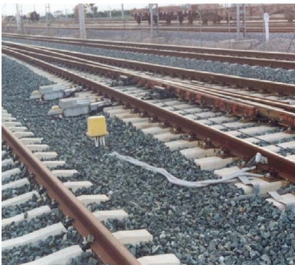
Fig. 2. Señalización lateral, accionamientos eléctricos de aguja y sensor de rueda.
