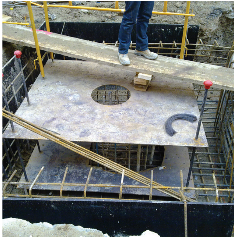
Fig.12. Viga de atado de los pilotes y cimentación de la "cadena" de conductos de la "VSM" en Gerona/Tie beam of the piles and foundations of the "chain" of pipes of the "VSM" in Gerona.
