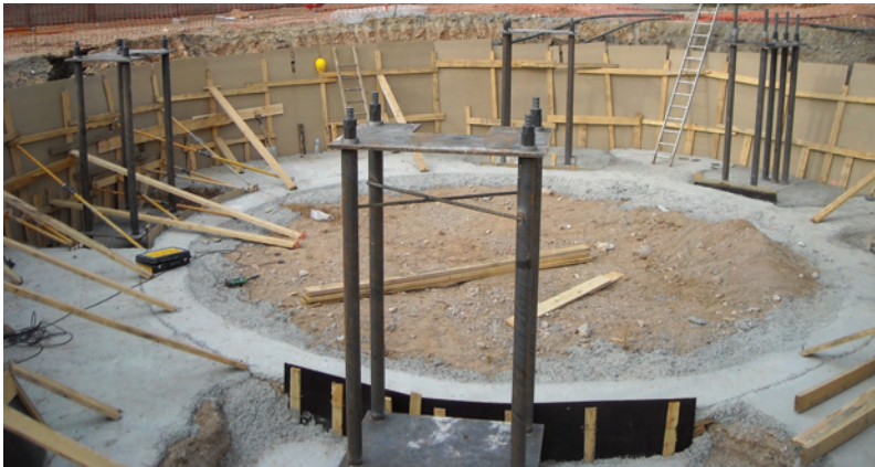
Fig. 2. Excavación previa con sostenimiento del terreno y cimentación de instalaciones/ Prior excavation with support of the site and foundation of the installations.
