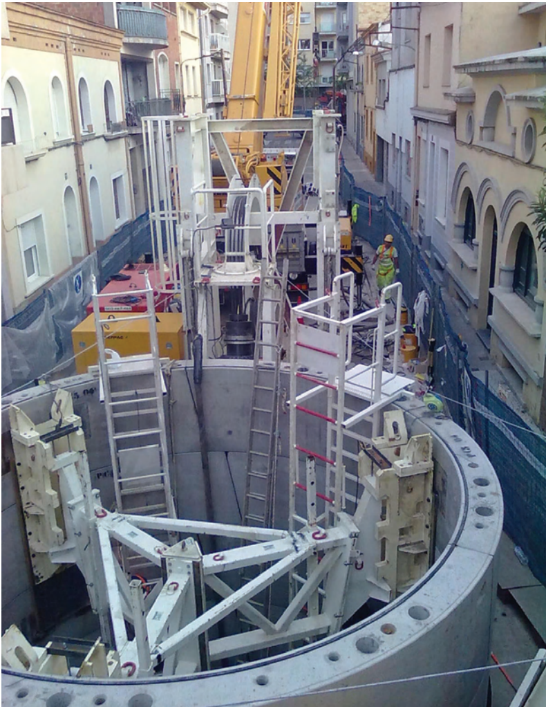
Figura 13.- Vista general de uno de los Pozos de Gerona. Colocación de las piezas de apoyo de la máquina/Overview of one of the Shafts in Gerona. Placement of the parts supporting the machine.
