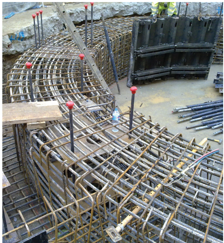
Fig.12. Viga de atado de los pilotes y cimentación de la "cadena" de conductos de la "VSM" en Gerona/Tie beam of the piles and foundations of the "chain" of pipes of the "VSM" in Gerona.
