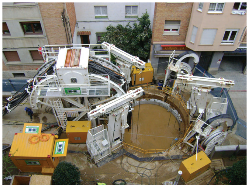
Figura 14.- Excavación de un pozo (Gerona)/Excavation of a shaft (Gerona).
