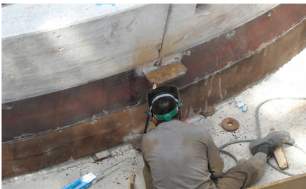
Fig. 3. Soldadura de la parte metálica del "anillo 0" del revestimiento/ Welding of the metallic part of "ring 0" of the lining.
