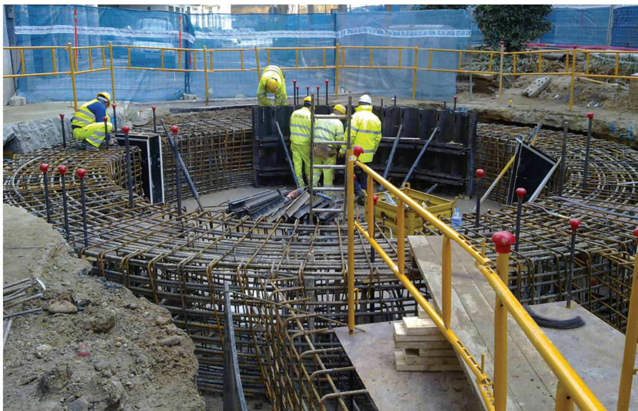
Fig.11. Vista general y detalle de la viga de atado de los pilotes que sirven de cimentación general de las instalaciones de cada pozo (Gerona)/ Overview and detail of the tie beam of the piles which serve as the general foundations of the installations of each shaft (Gerona).
