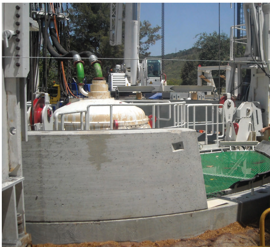
Fig. 8. "VSM" en el exterior para revisión. Vista de una de las grúas de elevación/ "VSM" in the exterior for revision. View of one of the raising cranes.
