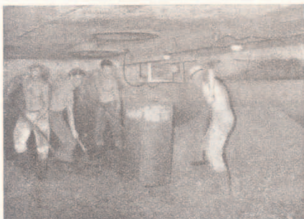
Fig. 1. a — Carga a mano. La tierra ha sido desagregada y apilada con pala semiautomática.
