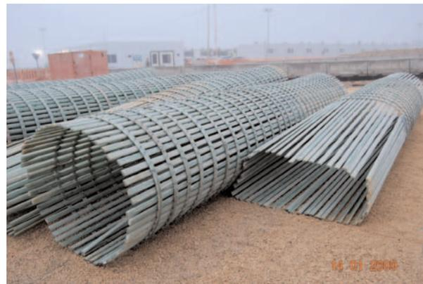
Fig. 44. Armaduras de fibra de vidrio para pilotes en El Regajal.
