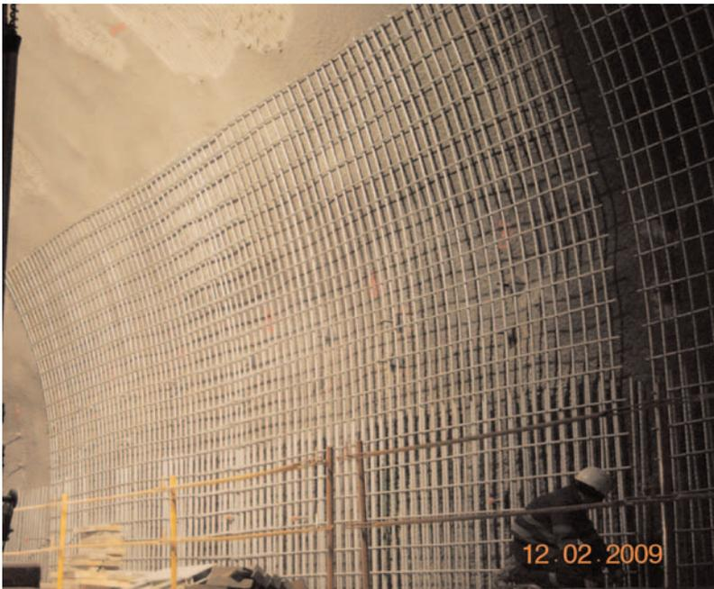
Fig. 36. Detalle de las armaduras en acero galvanizado colocadas en el túnel de El Regajal.
