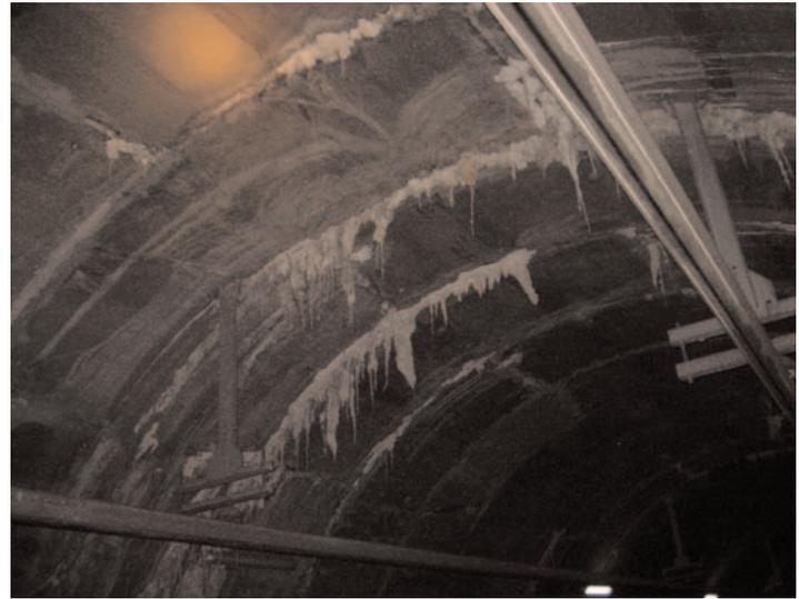
A la izquierda, fig. 39. Concentración de sales en una junta. A la derecha, fig. 40.- Estalactitas salinas.
