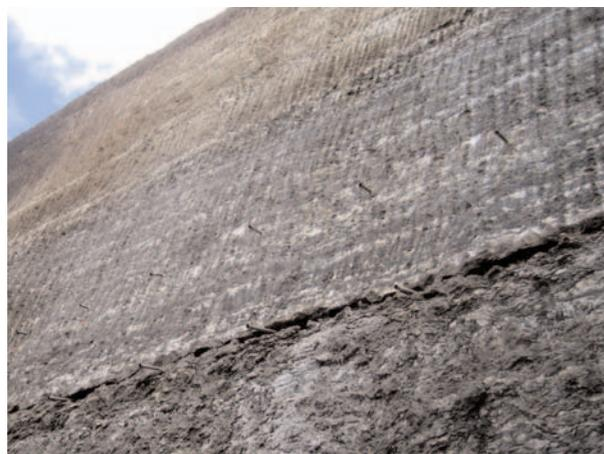
Fig. 21. Grieta de expansión al concentrarse el agua sobre una capa impermeable y transformar la thenardita en mirabilita.
