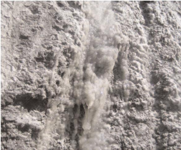
Fig. 19. Surgencia de agua cristalizada en mirabilita. A la derecha, Fig. 20. Diagrama de fases del sulfato sódico.
