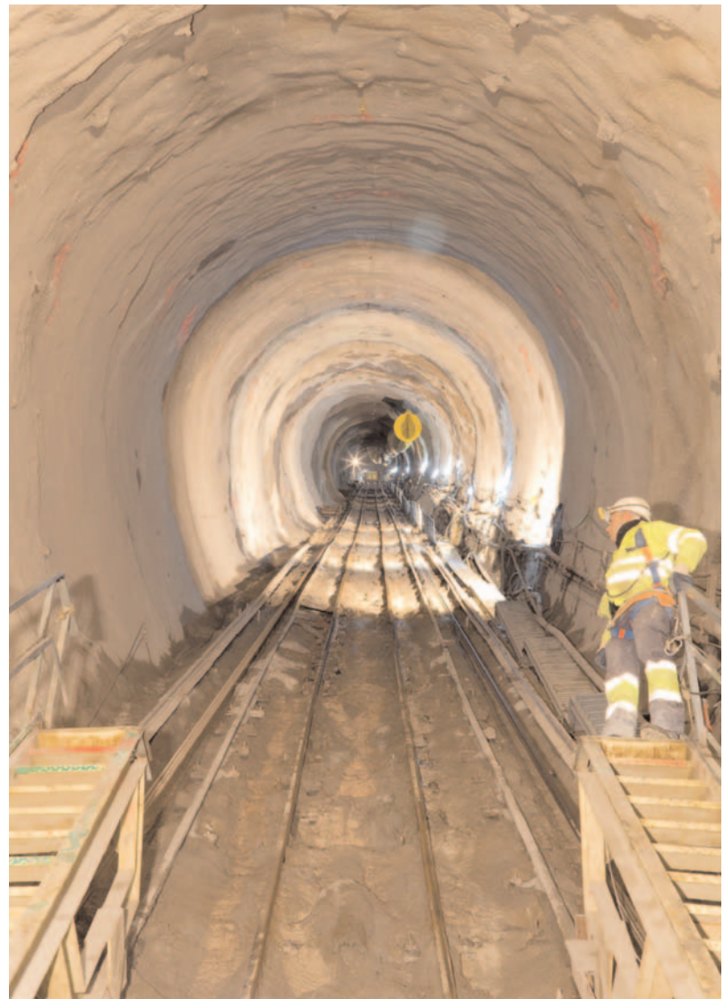
Fig. 14. Vista del tramo de pozo excavado con la sección final.
