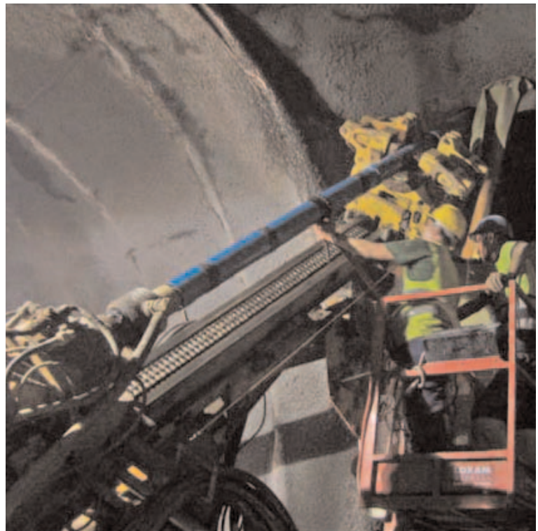
Fig. 10. Detalle de la colocación del tubo-manguito desde la galería auxiliar.
