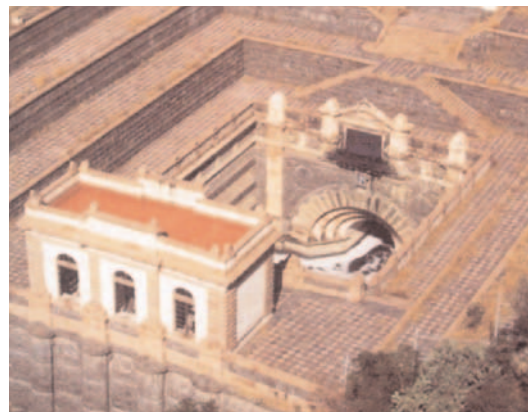
A la izquierda, fig. 6. Túnel urbano en Guanajuato. A la derecha, fig. 7. Embocadura del túnel de drenaje de Tequisquiác.
