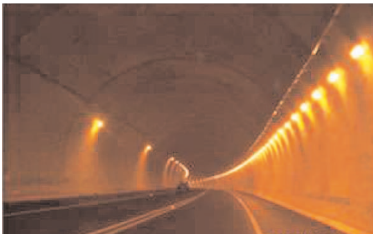
Fig. 14. Túnel en servicio en la autopista Amozoc-Perote. (Poon, 2009).
