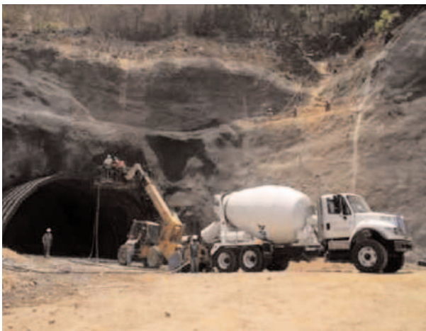
Fig. 16. Autopista Durango-Mazatlán. Portal en construcción (Poon, 2009).
