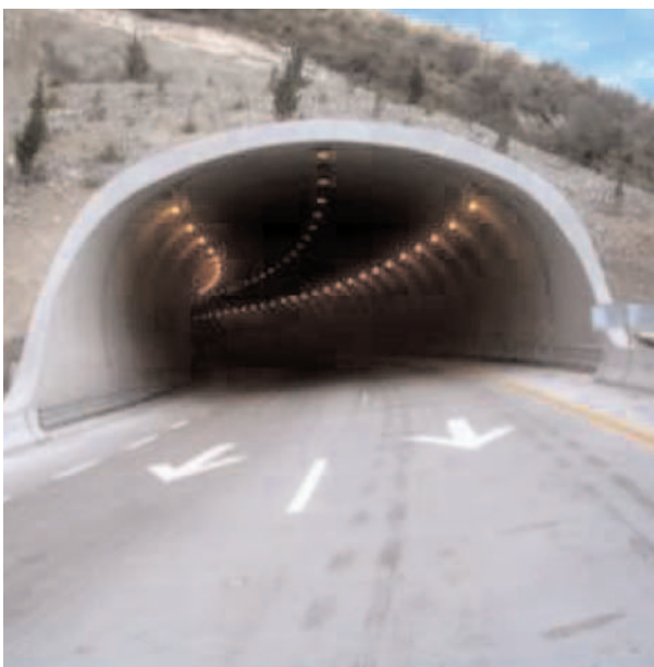
Fig. 17. Autopista Durango-Mazatlán. Túnel construido. (Poon, 2009).
