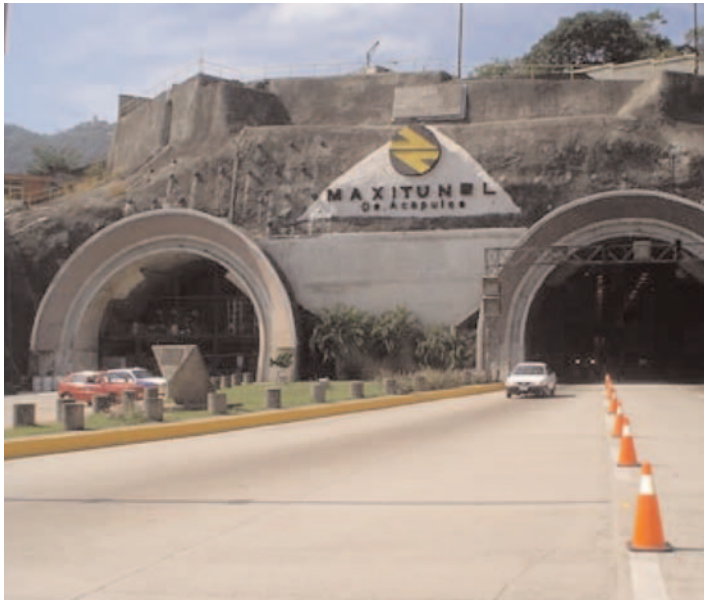
A la izquierda, fig. 12. Bocas del Maxitúnel de Acapulco. A la derecha, fig. 13. Interior del Maxitúnel de Acapulco.
