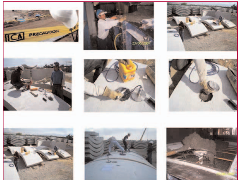
Fig. 11. Dovelas e instrumentación en el túnel de drenaje del Río de la Compañía (cortesía ICA).
