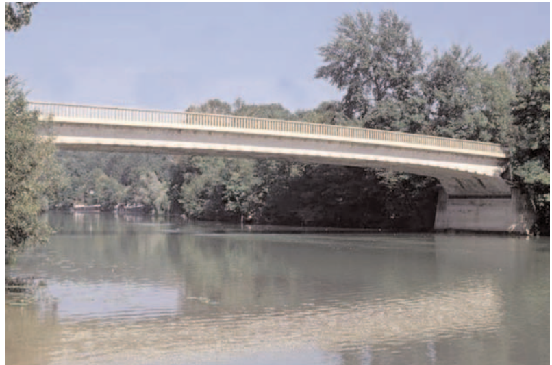
"Puente de Luzancy s/ el Marne, proyectado por Freyssinet en 1941, que utiliza por primera vez las ventajas del pretensado en el proyecto y la construcción". Foto Carlos Nárdiz.
