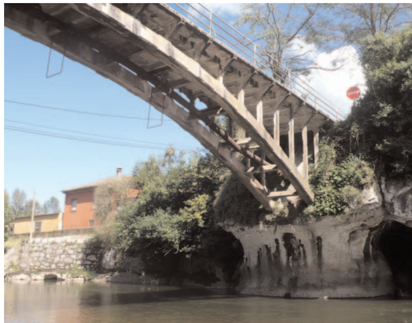
"Puente Golbardo en Cantabria. El primer puente con arco de hormigón armado construido en España". Foto Carlos Nárdiz.
