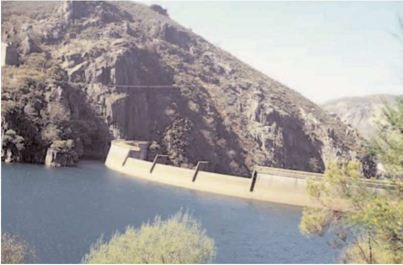
"Presa proyectada por Luciano Yordi en 1959 en el Eume (A Coruña) y que fue la primera presa bóveda de España". Foto Carlos Nárdiz.
