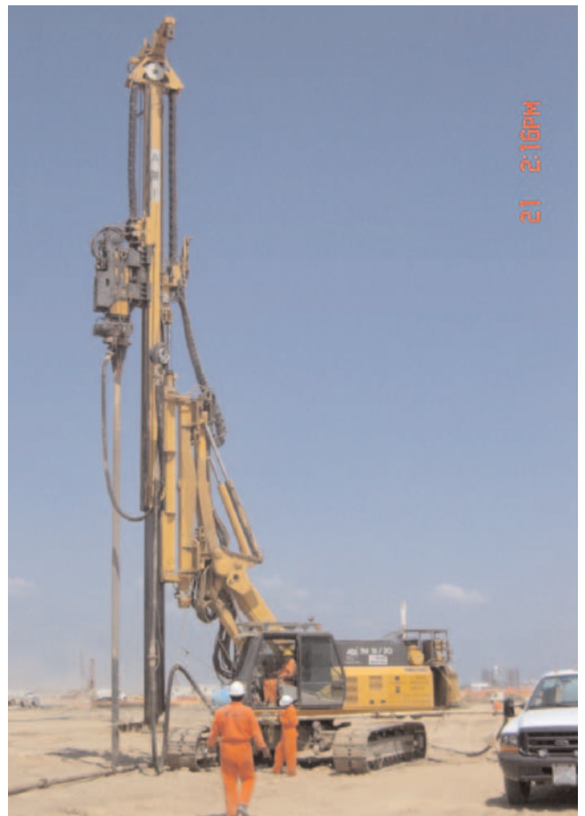
Fig. 22. Equipo utilizado para la perforación e inyección de mortero. (Gentileza de GEOCISA).
