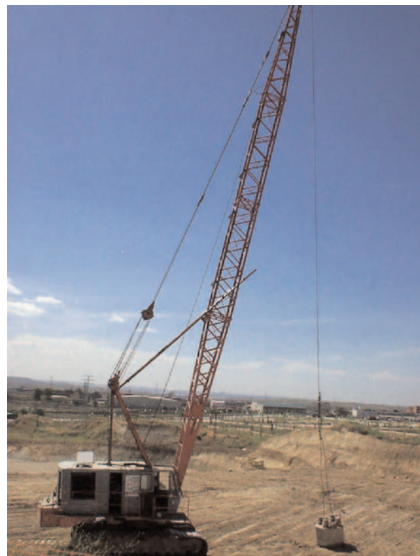
Fig. 14. Compactación dinámica realizada en la R3 de Madrid.
