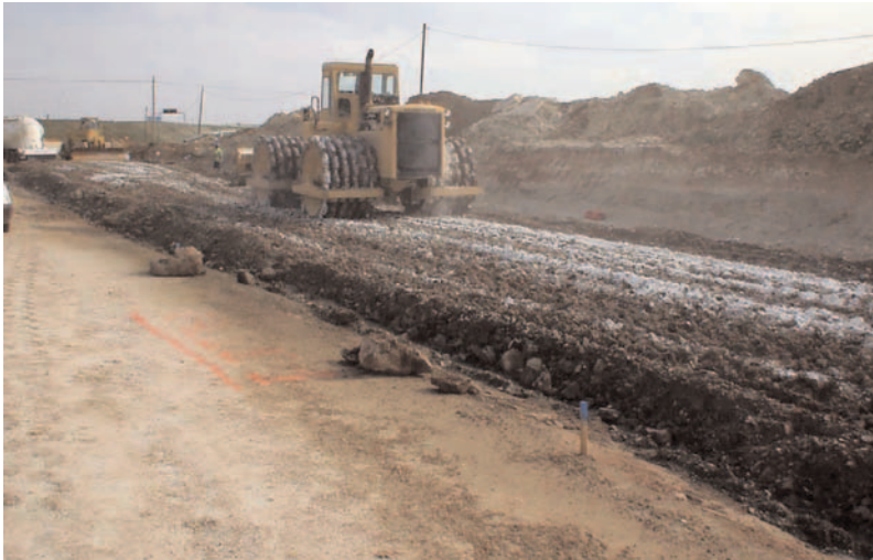
Fig. 4. Tratamiento de una arcilla expansiva con cal para formar el núcleo del terraplén de una Autovía.
