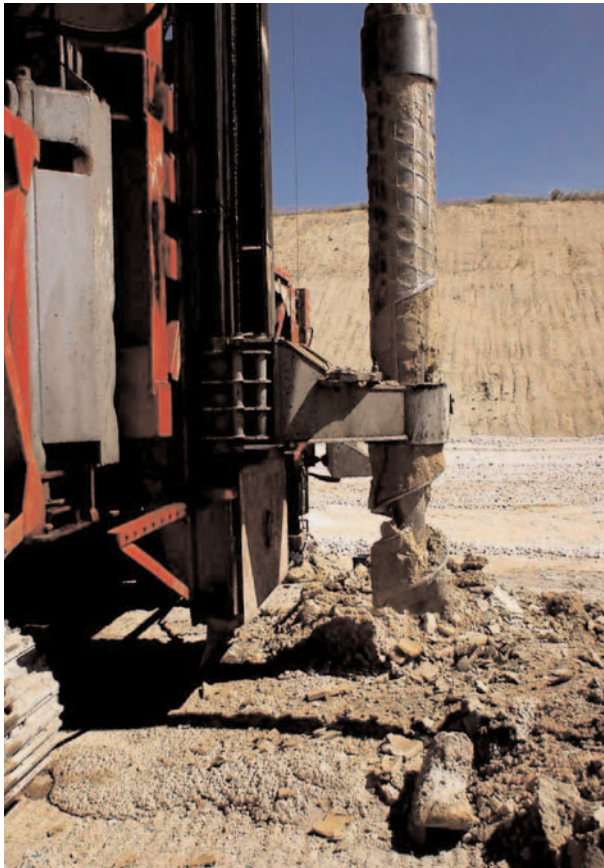
Fig. 19. Detalle del extremo del útil de perforación para columnas de mortero con desplazamiento (Gentileza de MENARD).
