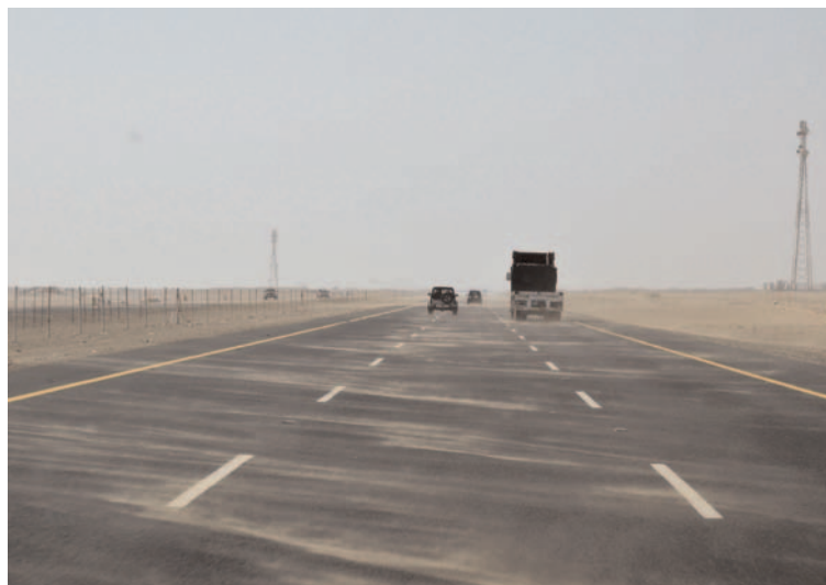
Fig. 9. Flujo de arena cruzando la autopista Jeddah-Riyadh, facilitado por un diseño apropiado del trazado. Fotografía de los autores/Wind-blown sand crossing the Jeddah-Riyadh Expressway, enhanced by appropriated design. Photograph taken by the authors.
