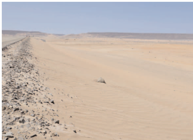
Fig. 3. Lado sotavento de la plataforma con acumulaciones de arenas en los taludes del terraplén. Fotografía de los autores/ Leeward side of the railway with accumulations of sand on the slope of the embankment. Photograph taken by the authors.
