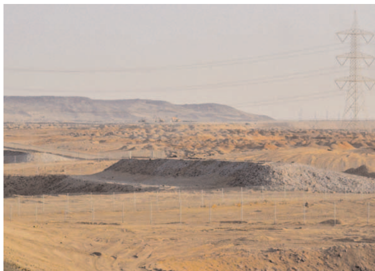
Fig 12. Mota cubierta con encachado para protección en lado barlovento del ferrocarril Haramain. Fotografía de los autores/Stone covered sand barrier on windward side of the embankment. Photograph taken by the authors.
