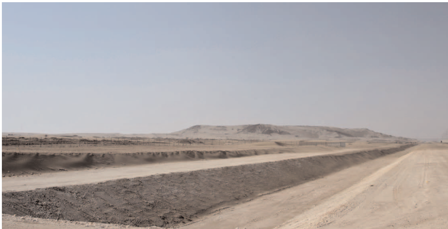
Fig. 11. Trinchera para captación de arenas situada a barlovento del ferrocarril Haramain. Fotografía de los autores/ Ditches for trapping sand on the windward side of the Haramain railway embankment. Photograph taken by the authors.
