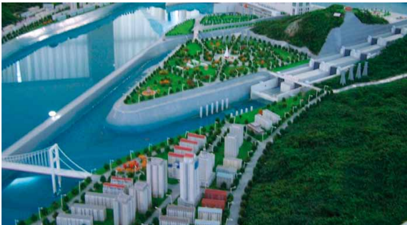
Fig. 3. Una maqueta del Proyecto de las Tres Gargantas en el río Yangtze, de derecha a izquierda: cinco esclusas de barcos, incluyendo los canales de acceso superior e inferior, el elevador de buques y su canal, la central izquierda de energía, el aliviadero, y la central derecha de energía
