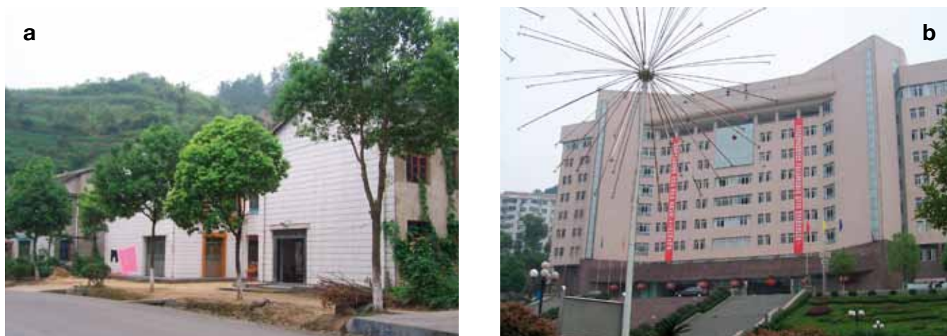
Fig. 12. (a) Nuevo pueblo construido en la ladera superior a 185 m alrededor de la presa para el reasentamiento de las personas de la zona sumergida, (b) Ayuntamiento de nueva construcción en Kaixian (la ciudad vieja de Kaixian ha sido inundada por las aguas del embalse)
