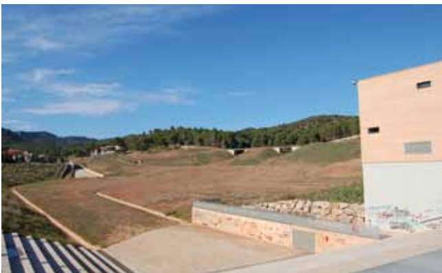
Fig. 3. Ejemplos de depósitos de retención en el Área Metropolitana de Barcelona
