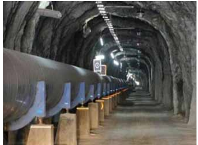
Fig. 10. Nuevo Acueducto II Querétaro
