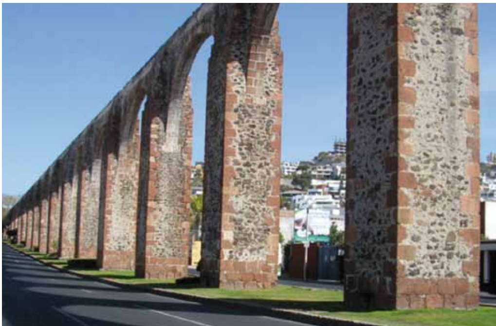
Fig. 9. Antiguo Acueducto de Querétaro construido por el Marqués de la Villa y del Villar del Ávila
