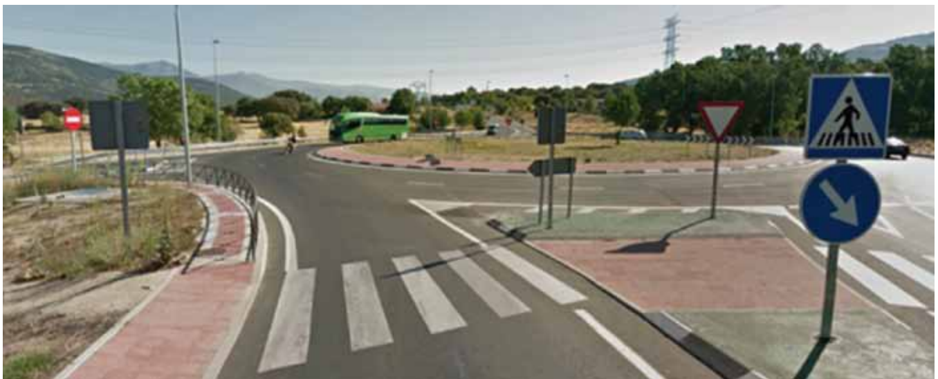
M-608. Remodelación del acceso y salida norte mediante una glorieta en Collado Villalba (Madrid)
