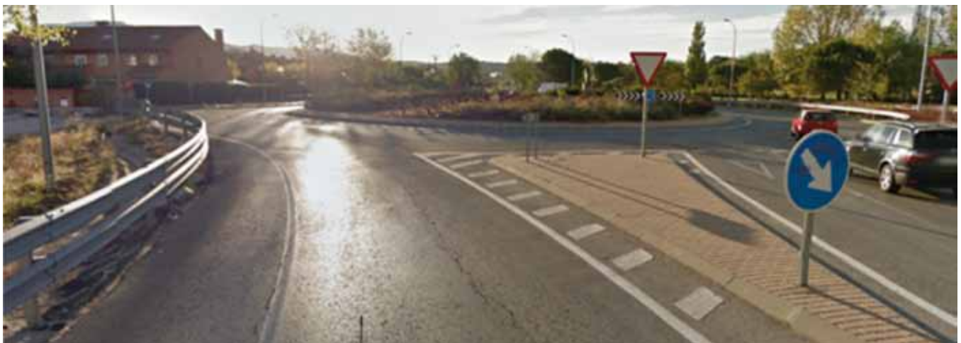
M-608. Glorieta de acceso a la urbanización El Soto en Collado Villalba (Madrid)
