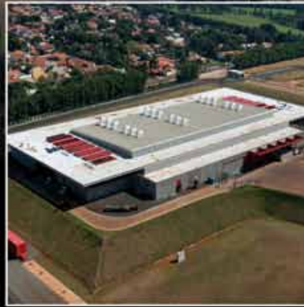
Gestión y Supervisión de Obra del Centro de Proceso de Datos del Grupo Santander en Brasil
