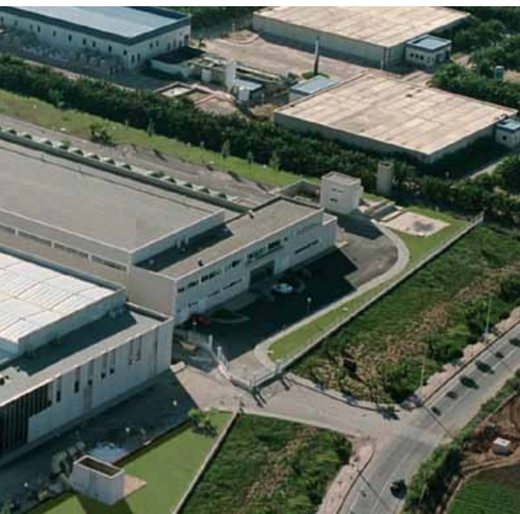
Fig. 2. Planta desaladora San Pedro del Pinatar 2
