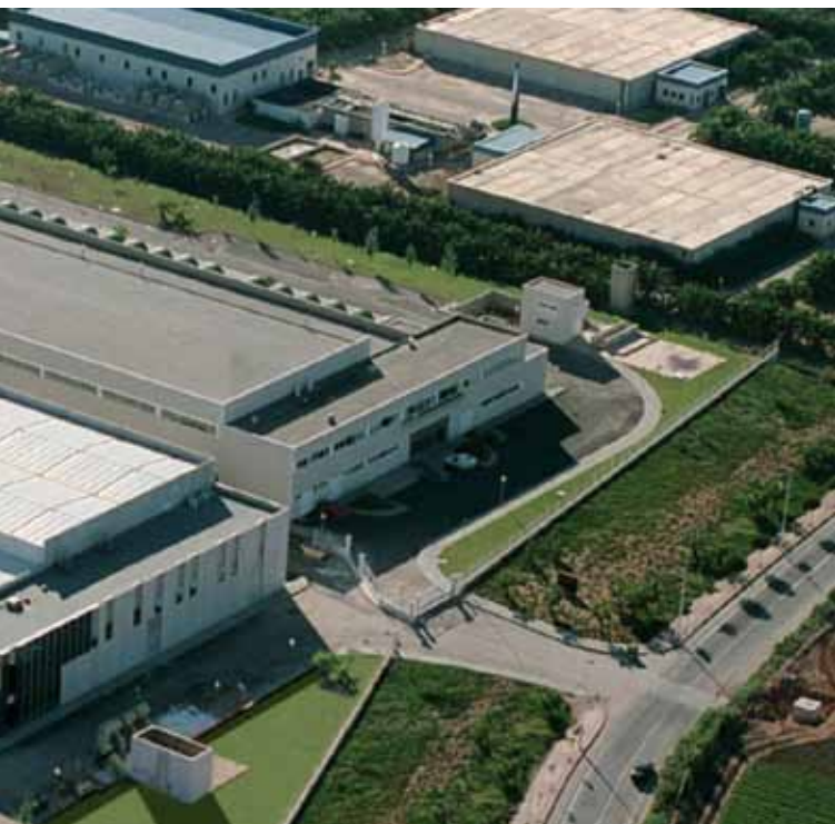
Fig. 2. Planta desaladora San Pedro del Pinatar 2
