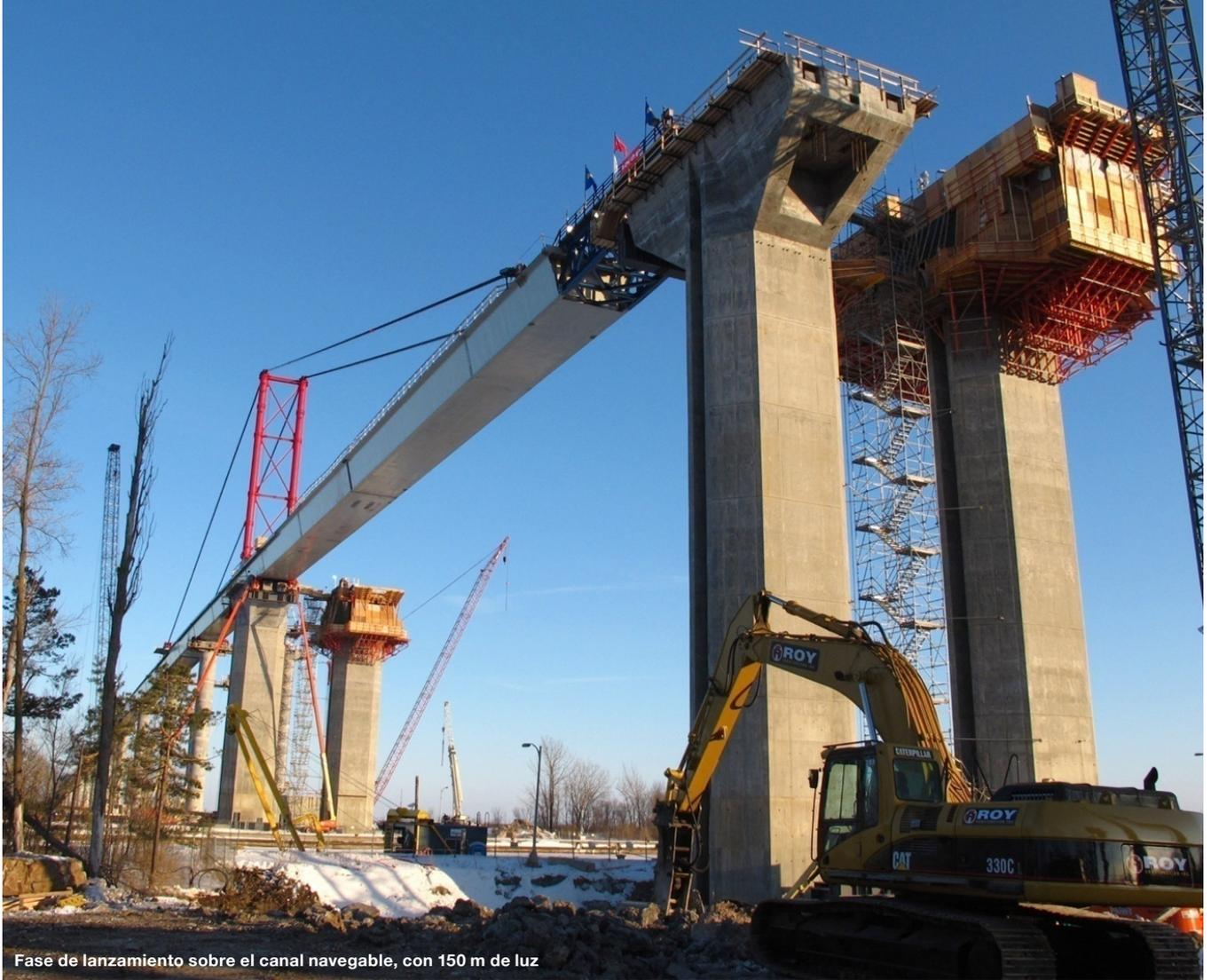
Fase de lanzamiento sobre el canal navegable, con 150 m de luz
