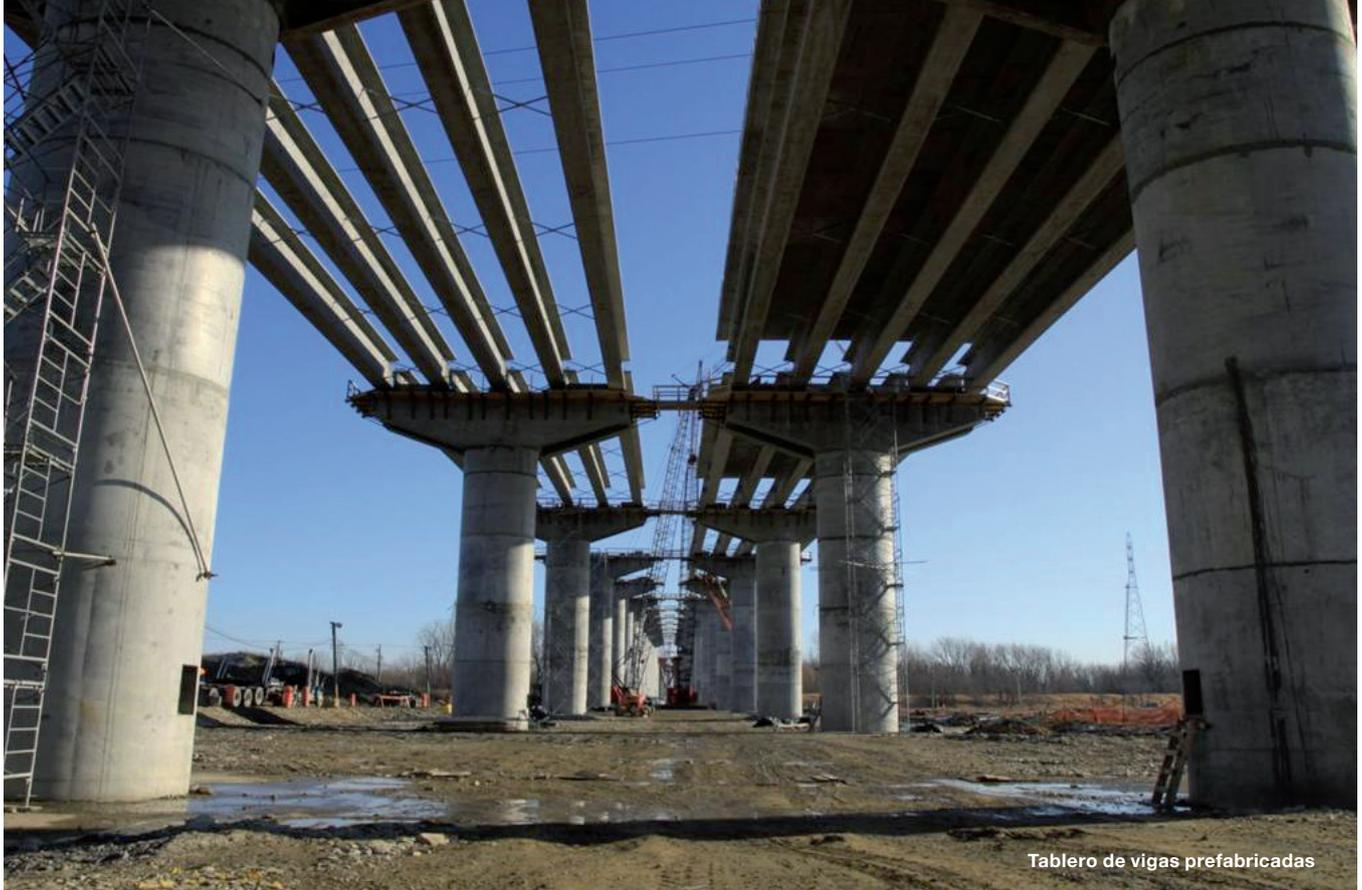
Tablero de vigas prefabricadas
