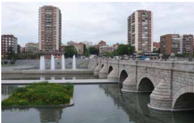
Fig. 9. Recuperación de las márgenes de Puente de Segovia / Recovery of the banks of the Puente de Segovia
