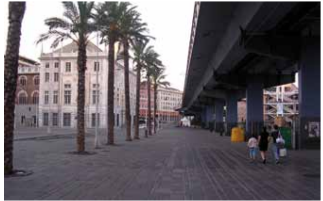
Fig. 11. Paso elevado en Génova ‘La sopraelevata’ / Overpass in Genoa “La sopraelevata”.
