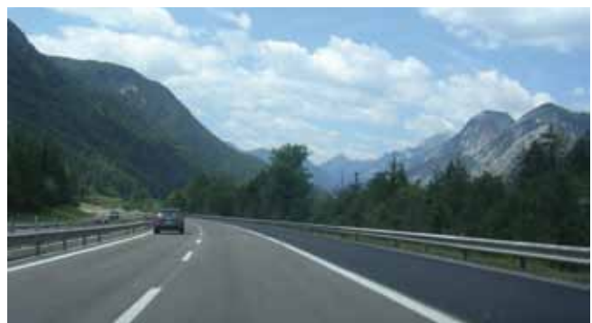
Fig. 2. Autopista atravesando los Alpes entre Viena y Venecia / Motorway crossing the Alps between Vienna and Venice
