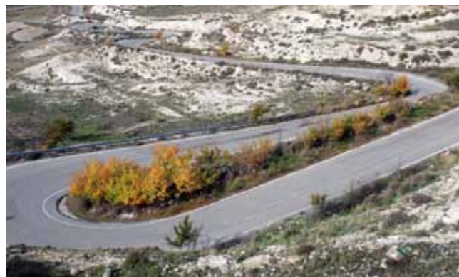
Fig. 2. Zig-zags de subida a la Muela en la carretera de Madrid a Barcelona. Habiendo quedado fuera del trazado de la A-2, es actualmente un tramo de competencia municipal y sirve únicamente para dar acceso a las parcelas colindantes
