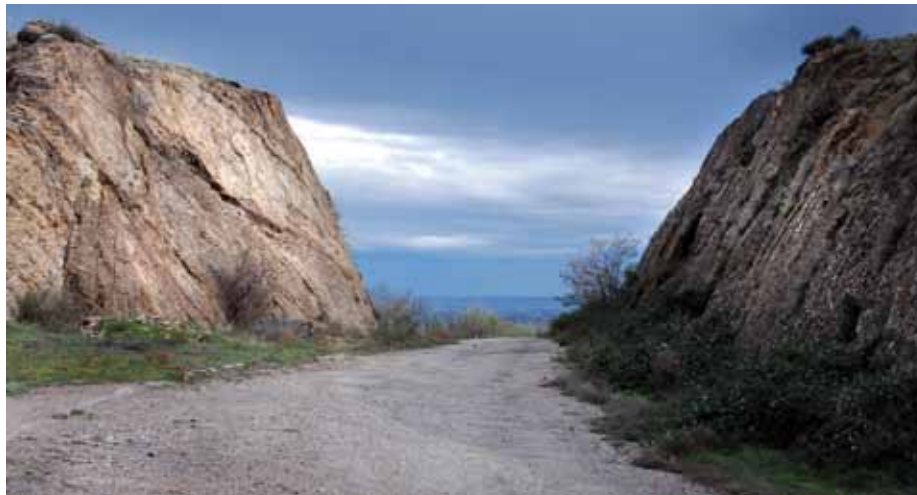
Fig. 6. Desmante de la Nacional II en el puerto de Morata (Zaragoza). Abandonado tras la construcción de un túnel alternativo, conserva la sección tipo introducida por el Circuito Nacional de Firmes Especiales. Hoy se emplea como camino rural y vertedero
