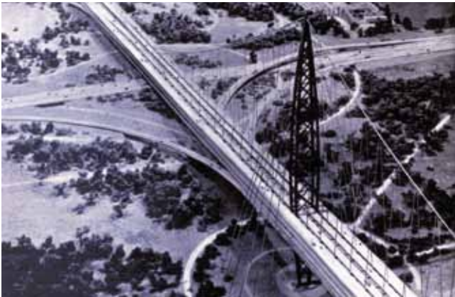
Fig. 9. Highways and Horizons. Puente de autopista de varios niveles
