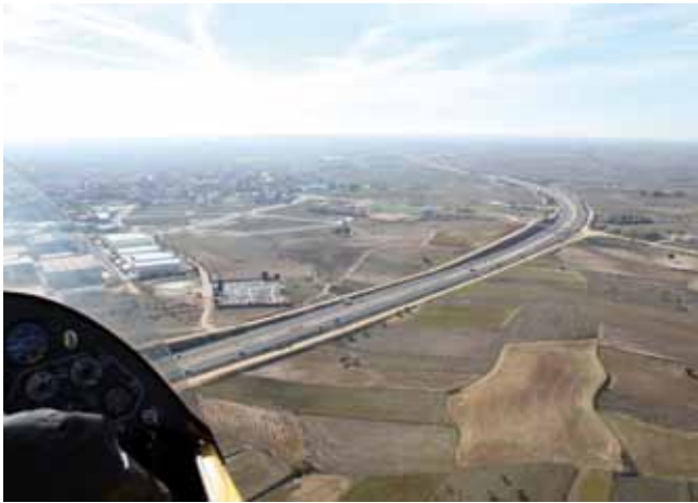
Fig. 12. La A-5 vista desde autogiro
