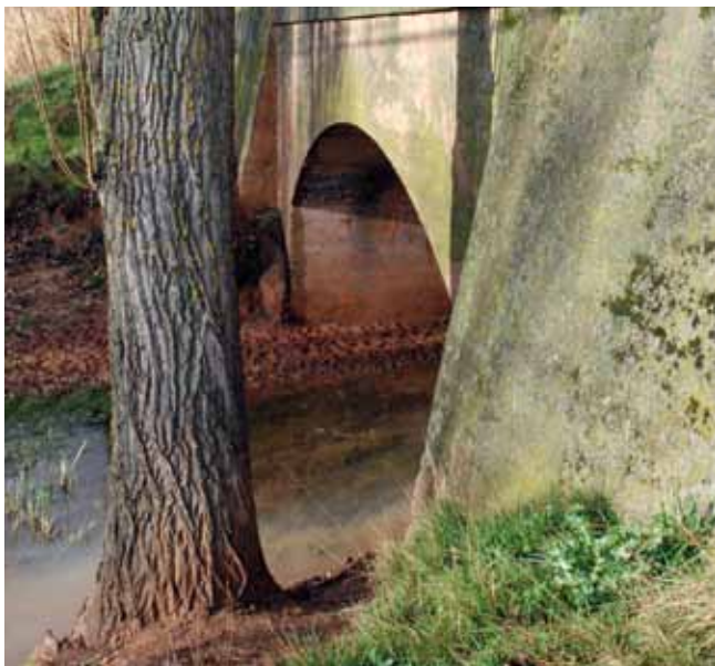
Fig. 5. Pontón en la variante de Olmedilla de Alarcón (Cuenca) construido en el contexto de las obras de mejora del Circuito Nacional de Firms Especiales en la carretera de Valencia. Obsérvese cómo reproduce la tipología clásica de pontón de fábrica definida por Lucio del Valle, pero utilizando el hormigón
