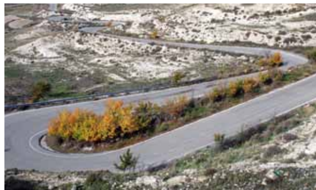
Fig. 2. Zig-zags de subida a la Muela en la carretera de Madrid a Barcelona. Habiendo quedado fuera del trazado de la A-2, es actualmente un tramo de competencia municipal y sirve únicamente para dar acceso a las parcelas colindantes
