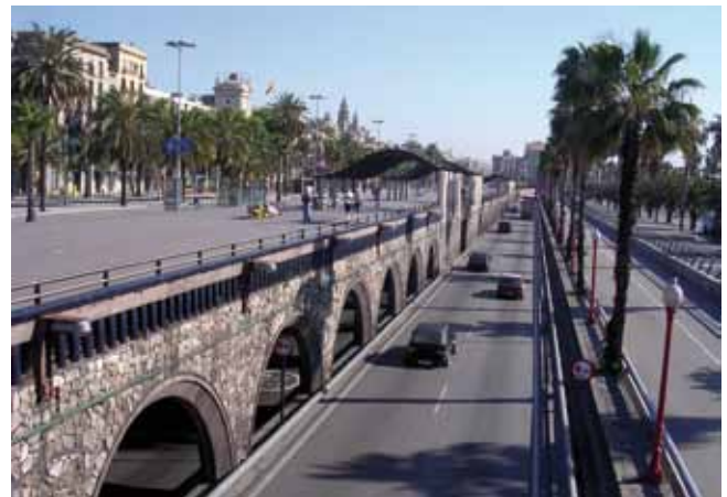
Fig. 6. Intervención en un tramo central de la ronda litoral a Barcelona (El Moll da Fusta) / Intervention on a central section of the Barcelona coastal bypass (El Moll da Fusta)
