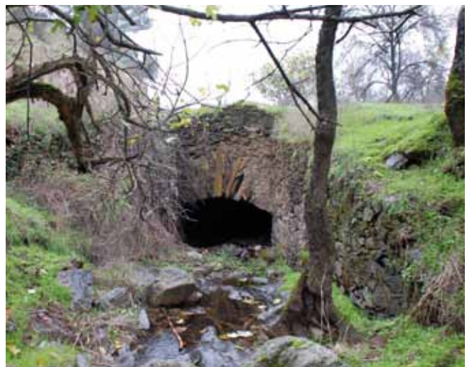
Fig. 4. Pontón sobre el arroyo Valdeazores, en Despeñaperros. Corresponde al trazado de la Carretera de Andalucía en la parte proyectada por Carlos Lemaur en la segunda mitad del S.XVIII. Situado en un tramo desafectado de uso, su recuperación puede verse facilitada por la construcción de las nuevas calzadas de la A-4
