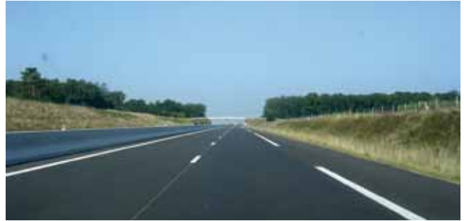
Fig. 4. Autopista A-85 en Francia entre Angers-Tours y Vierzon / A-85 Autoroute in France, between Angers-Tours and Vierzon
