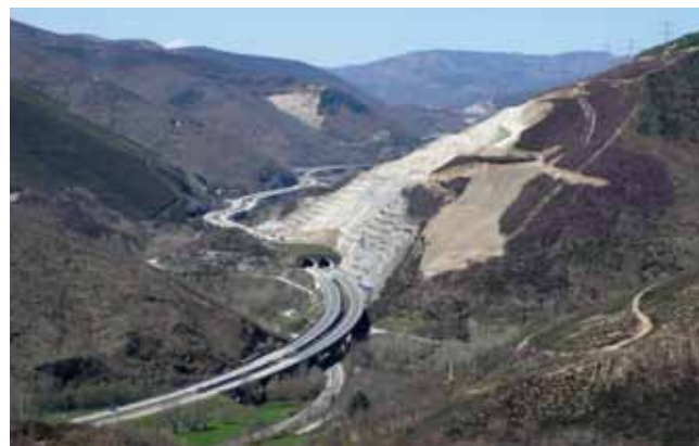
Fig. 5. Paso de la Autovía del Noroeste por el Valle de Valcarce / The Northwest Motorway passing through the Valle de Valcarce
