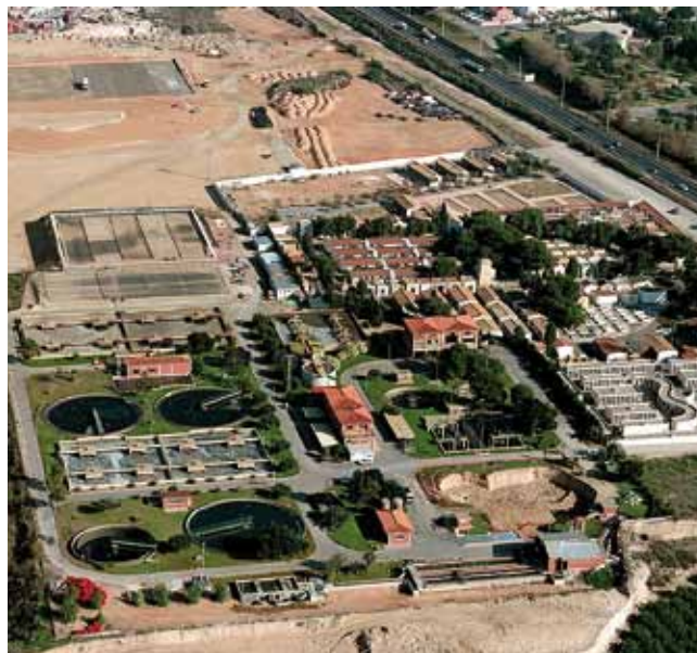
Depuradora de aguas residuales de Torreveja
