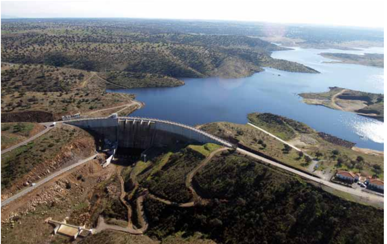
Presa de La Colada
