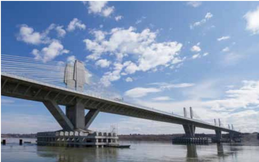
Vista general del Puente Vidin-Calafat
