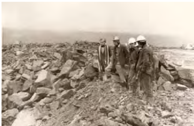
Obra de la presa de Úzquiza, año 1975. Juan Benet acompañado de Alfio Martín Olarte (con bufanda) y otros técnicos
