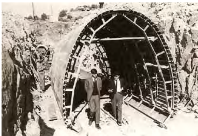
Año 1965, Benet, acompañado por Alfio Martín Olarte, bajo el encofrado del falso túnel del canal del Atazar
