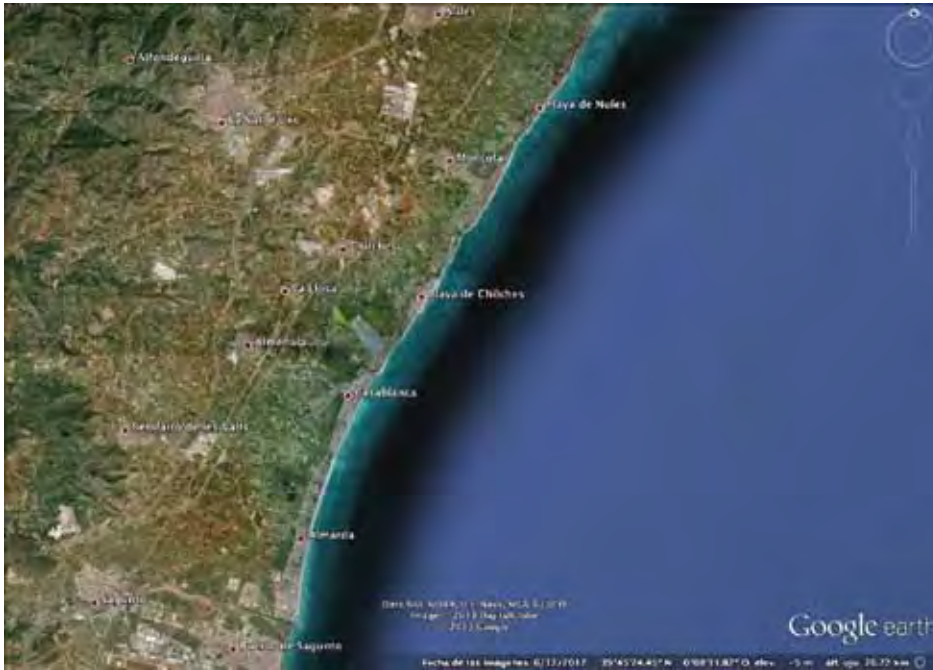
Fig. 3. Tramo de costa entre las desembocaduras de los ríos Mijares y Palencia. Foto de Google. Obras de protección de la costa en todo el tramo, especialmente de los núcleos de población edificados sobre los cordones litorales de dunas, arenas y gravas
