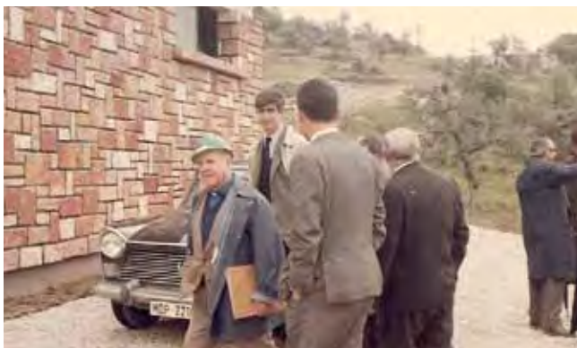
Obra del Atazar. Llegada a las oficinas de la Administración. En la imagen, Benet y otros responsables. Mayo de 1967
