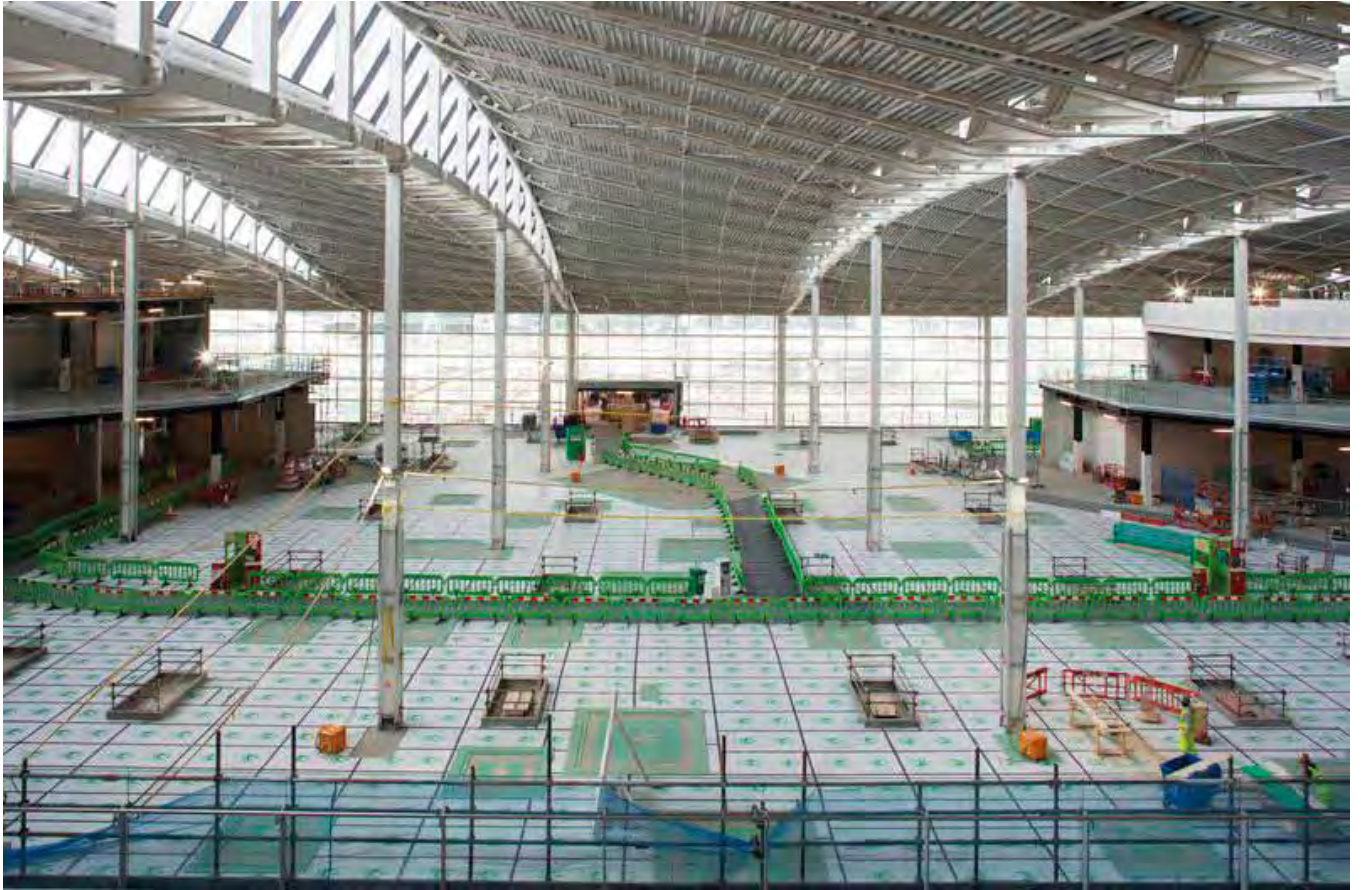
Terminal 2A del aeropuerto de Heathrow. Los lucernarios, orientados al norte, permiten captar al máximo la luz natural y reducir el consumo de energía
