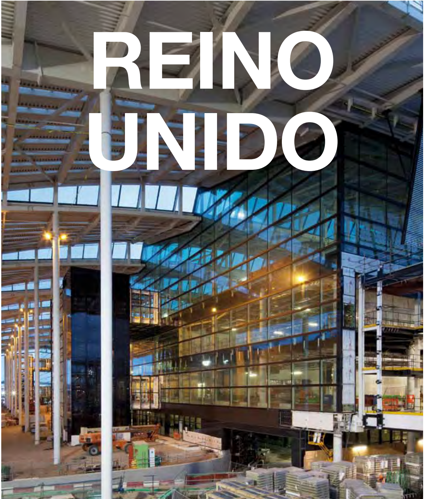
Obras del aeropuerto de Heathrow
