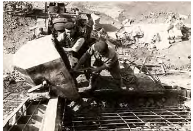
Hormigonado de paramento del canal Quereño y Cornatel, a finales de los años 50
