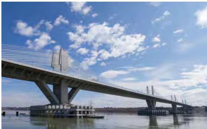
Vista general del Puente Vidin-Calafat
