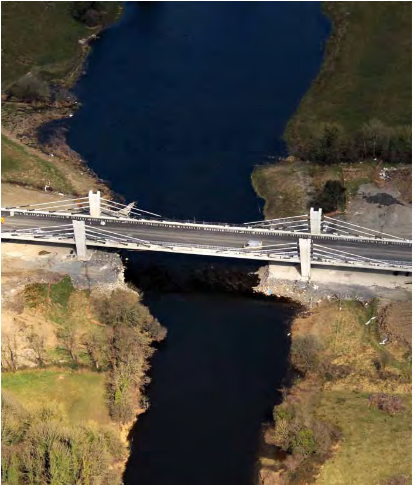
Uno de los puentes atirantados en construcción en las islas británicas
