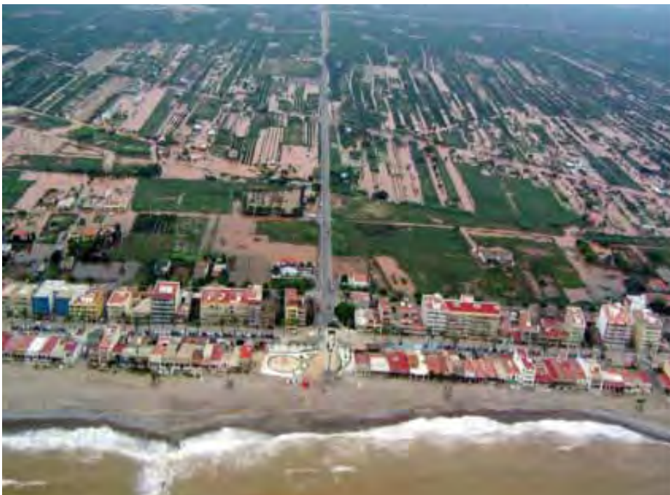
Fig. 2. Inundación de Playa de Nules (Castellón) y su entorno terrestre. Efecto presa de la zona urbanizada y del sistema de protección de la costa (espigones y aportaciones de arena)
