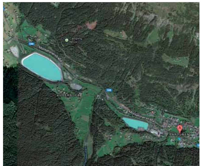
Fig. 4. Emplazamiento de la central de Kops II Fuente: Google Maps
