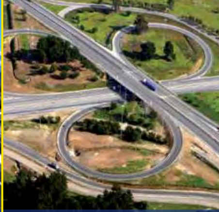
▲ Nuevo acceso al Puerto de San Antonio. Chile.
