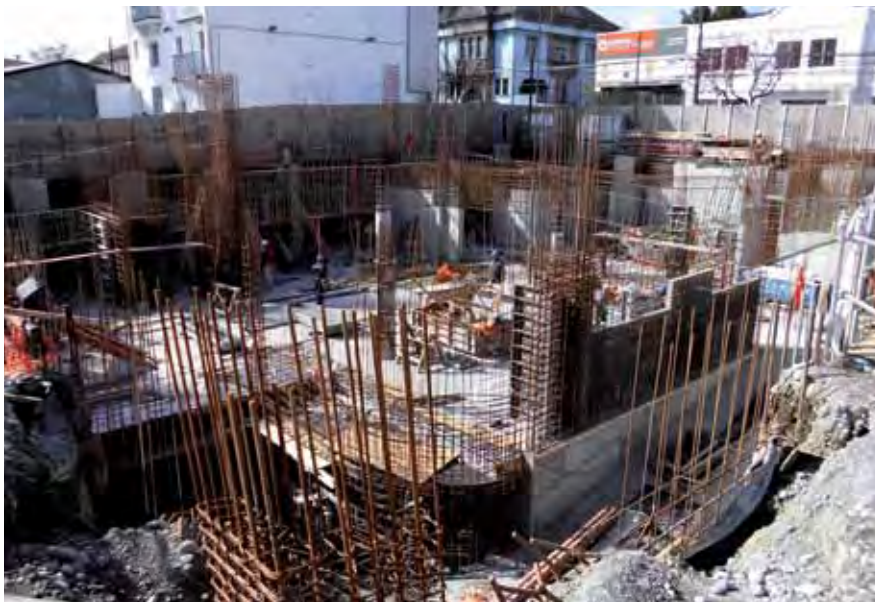
Construcción del edificio consistorial de Osorno (Ecisa)
