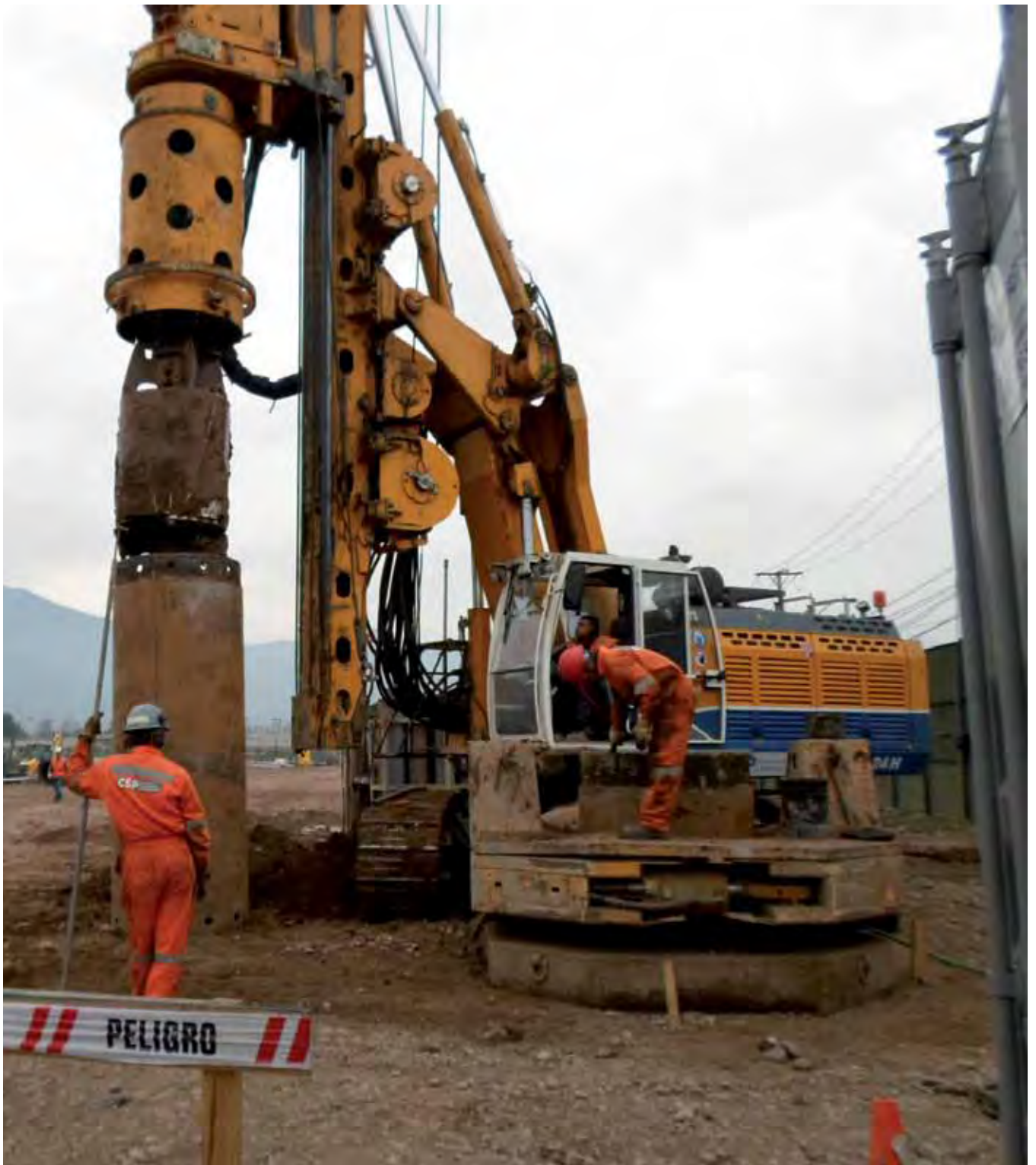
Excavación para el metro de Santiago (OHL)
