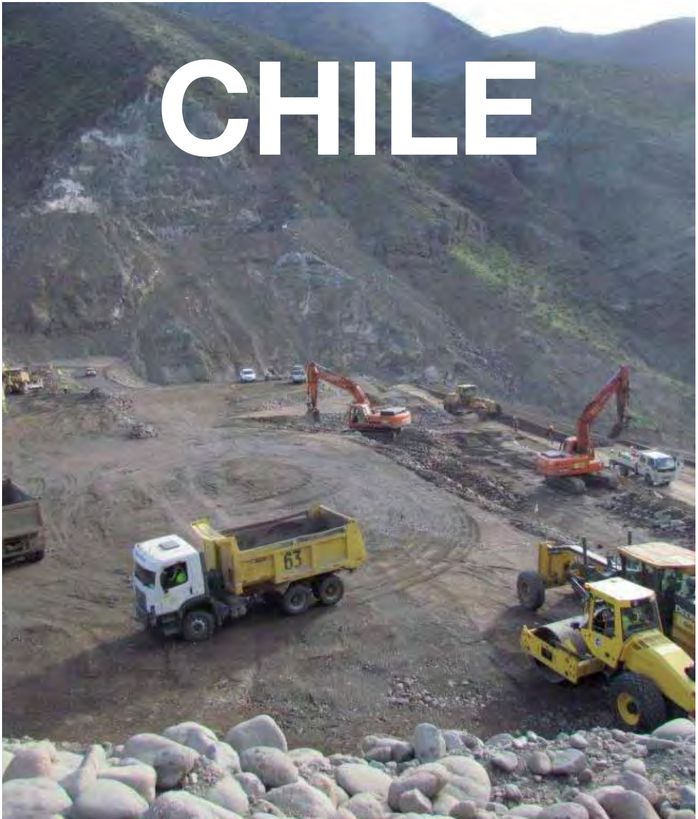
Construcción del embalse Chacrillas (OHL)
