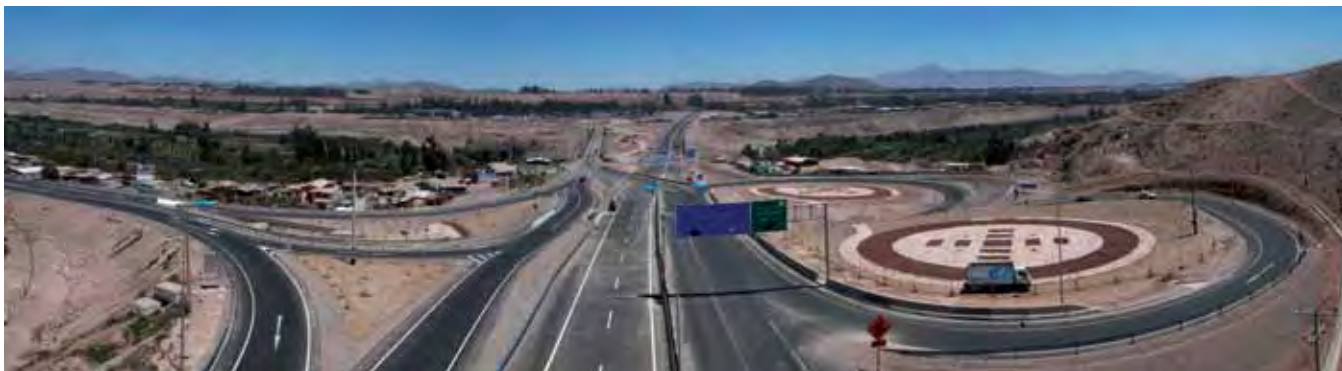
Vista panorámica de la autopista Vallenar-Caldera (Sacyr)
