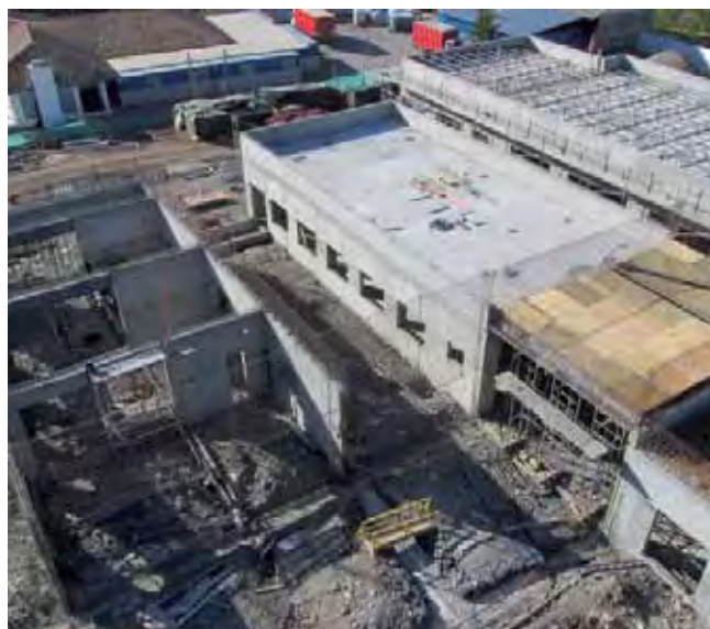
Construcción del hospital de Salamanca (Grupo Ortiz)
