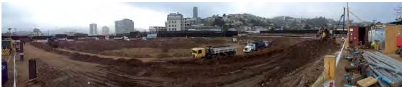
Obras del hospital Gustavo Fricke (OHL)
