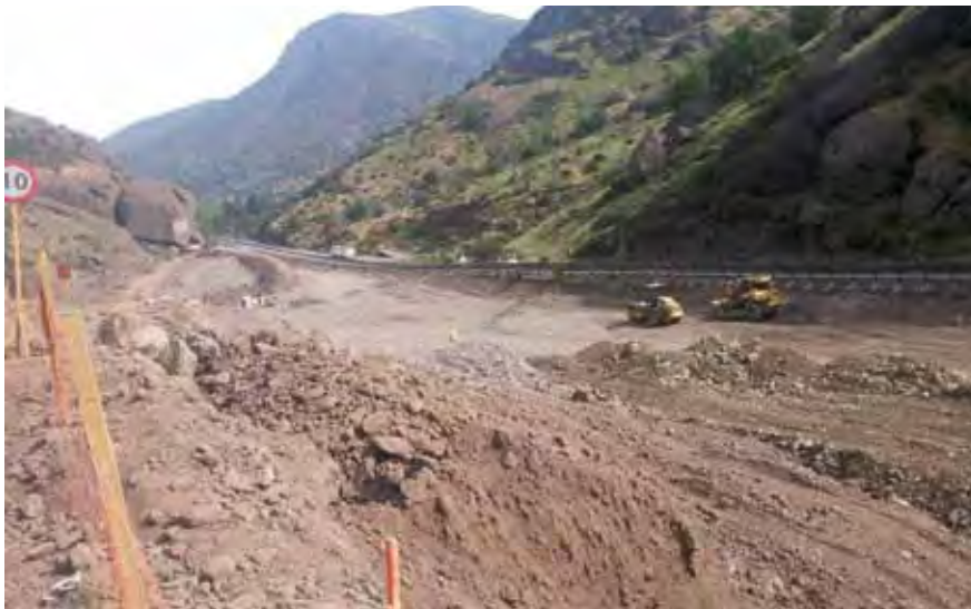
Terraplén sobre el estero Los Loros (FCC)
