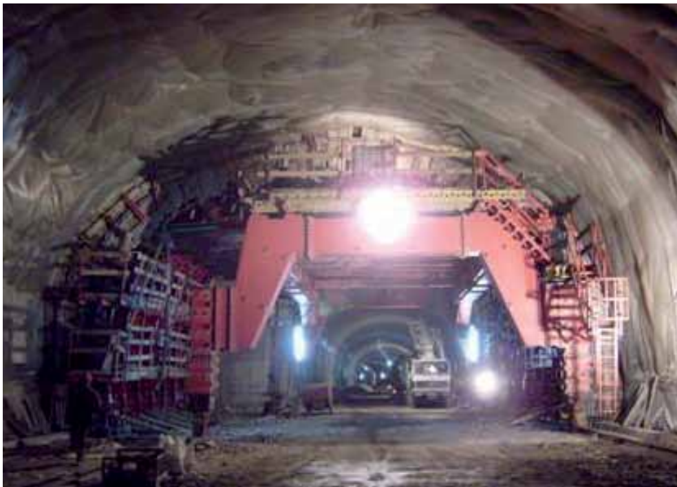
Fig. 23. Revestimiento. Carro encofrado y carro en apartadero
