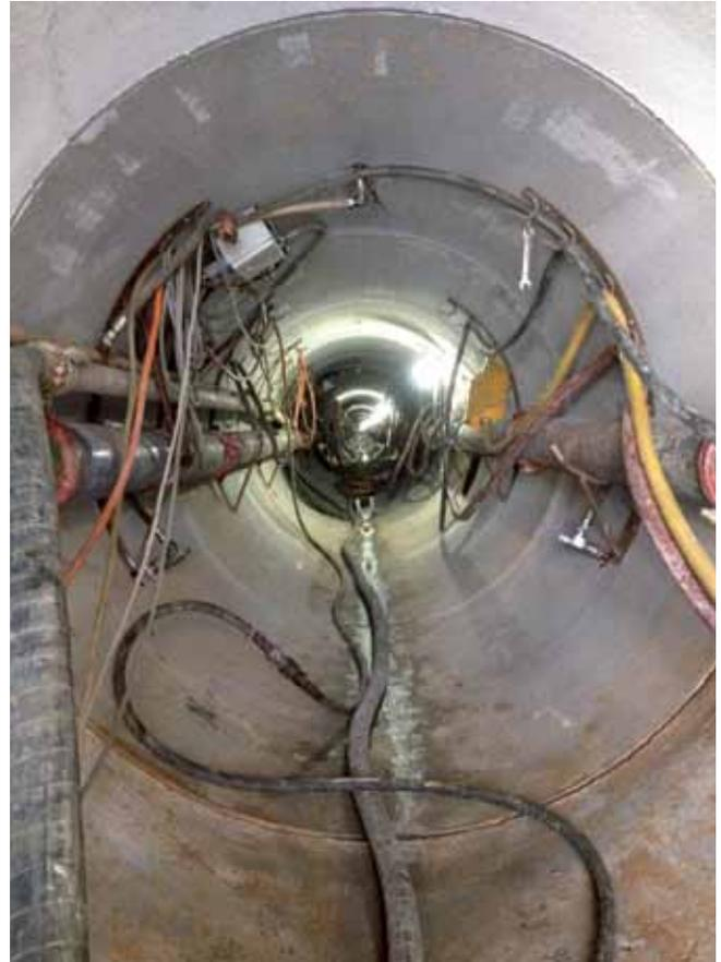
**Fig. 4. Foto del interior del túnel que muestra cajas e inyectores de bentonita (BALCE)**
