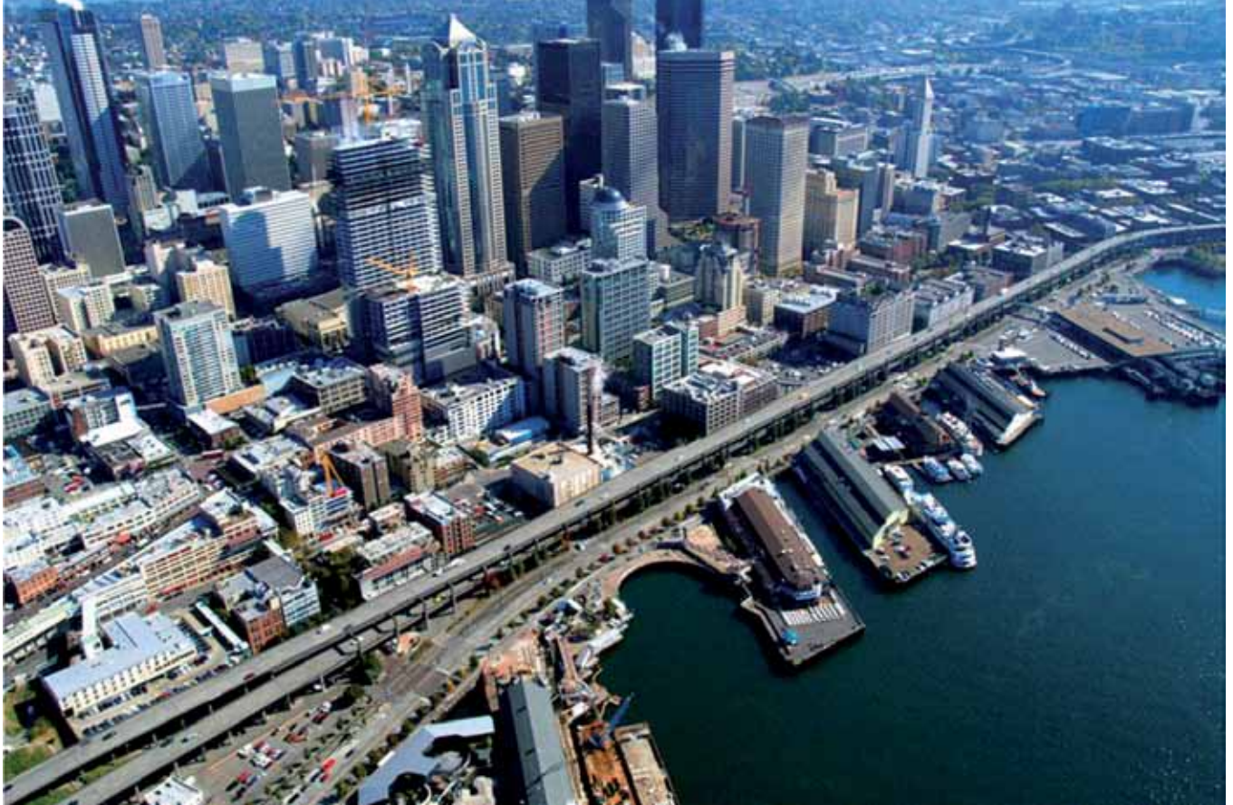
Fig. 1. Vista panorámica del centro de Seattle, línea de costa y el viaducto Alaskan Way
