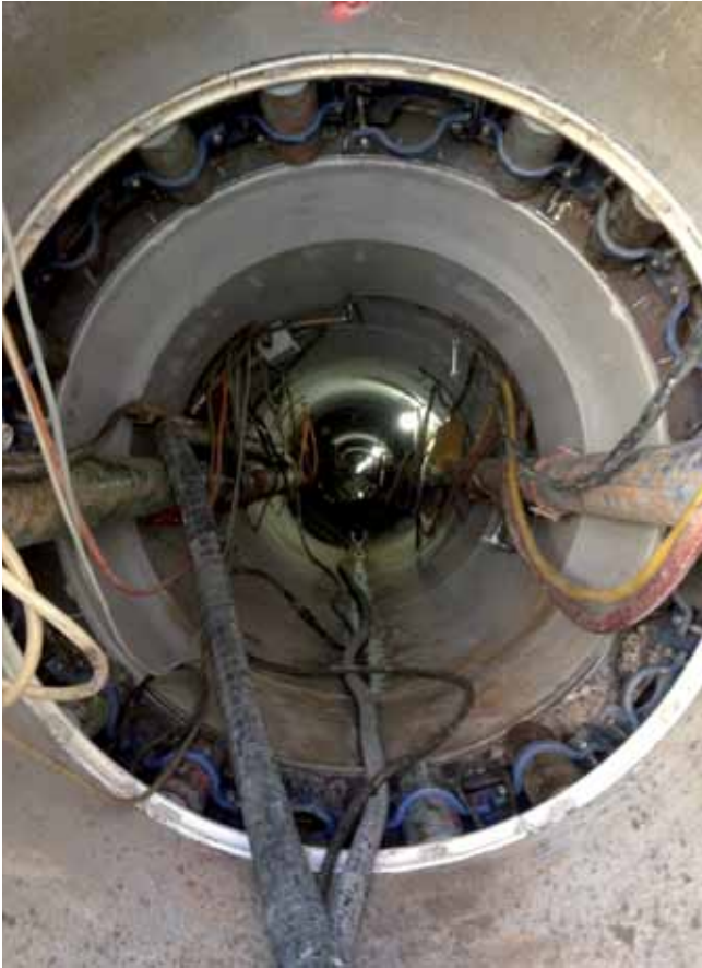
Fig. 3. Foto del interior del túnel que muestra una de las estaciones intermedias (BALCE)
