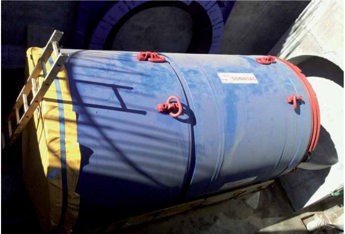
Fig. 2. Foto de la máquina situada en el pozo antes de la realización de la hinca (BALCE)
