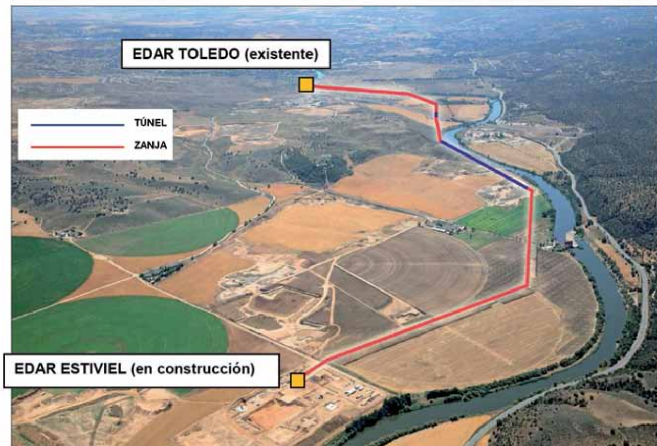
Fig. 1. Foto de situación de las obras de conducción
