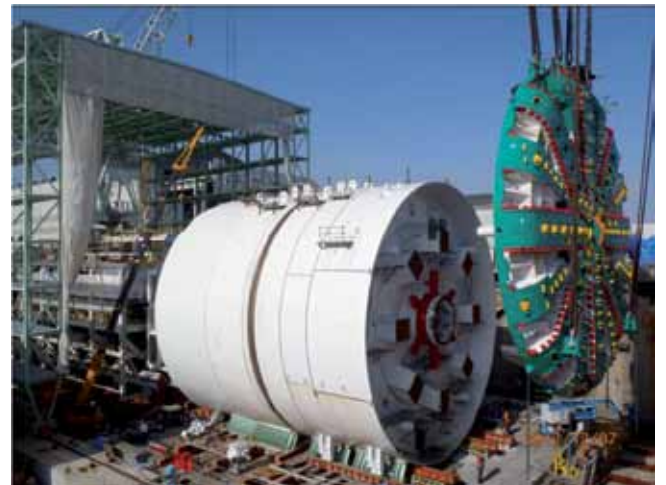
Fig. 2. Montaje de la rueda de corte (Ø= 17.56 m)
