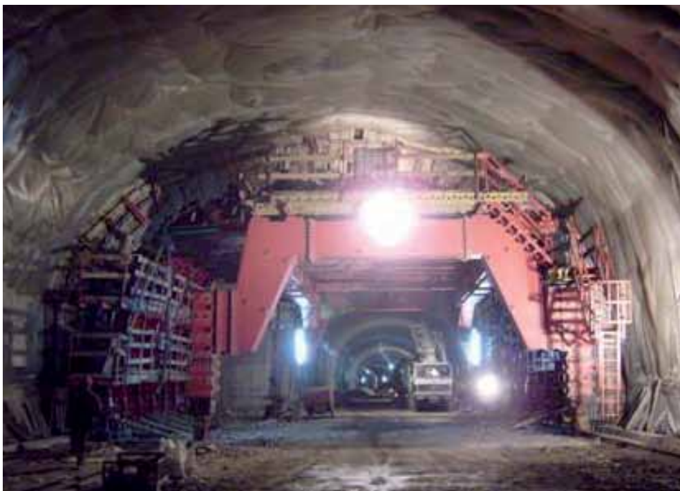
Fig. 23. Revestimiento. Carro encofrado y carro en apartadero
