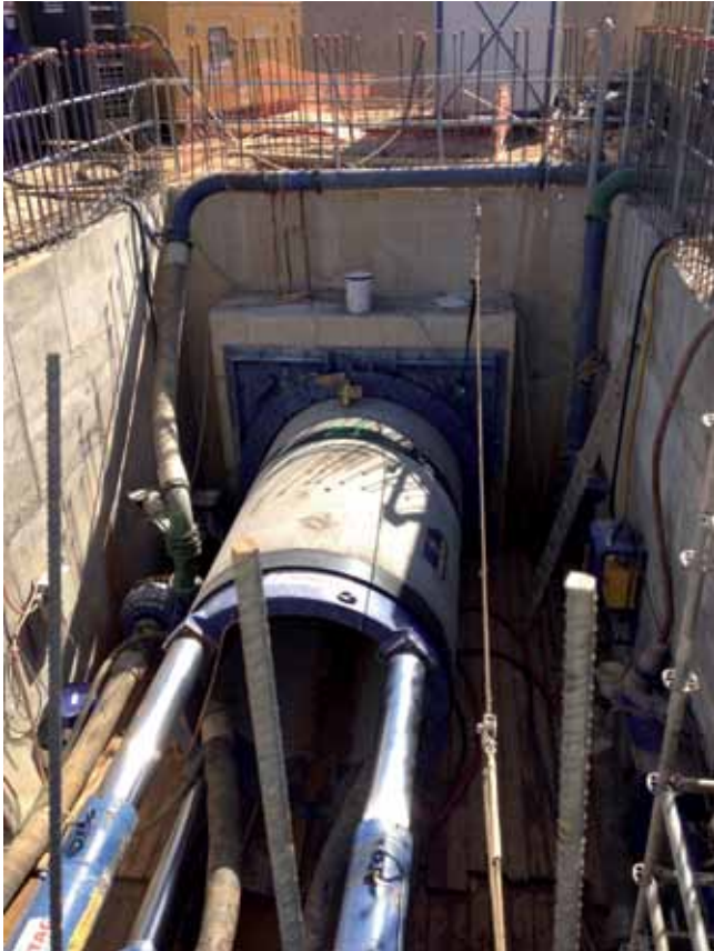
Fig. 5. Foto del pozo de ataque y cuna para disposición de tubos (Balce)
