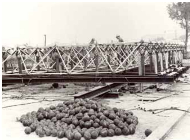
Fig. 6. Proceso de montaje de las cubiertas espaciales metálicas
