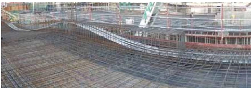
Viga upstand postesada en cubierta
