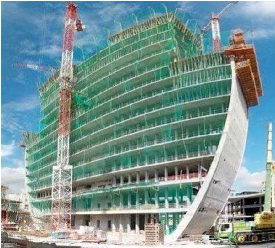
Muros testeros de espesor variable, pilares de fachada y núcleo rígido en una etapa intermedia
