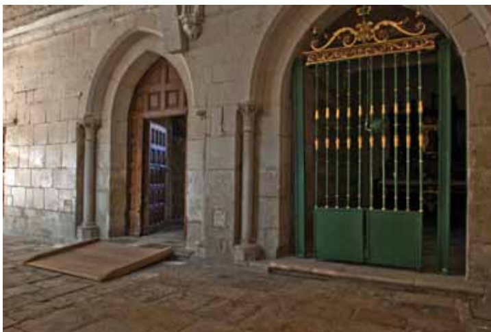
Rampas de acceso en distintas galerías del monasterio
