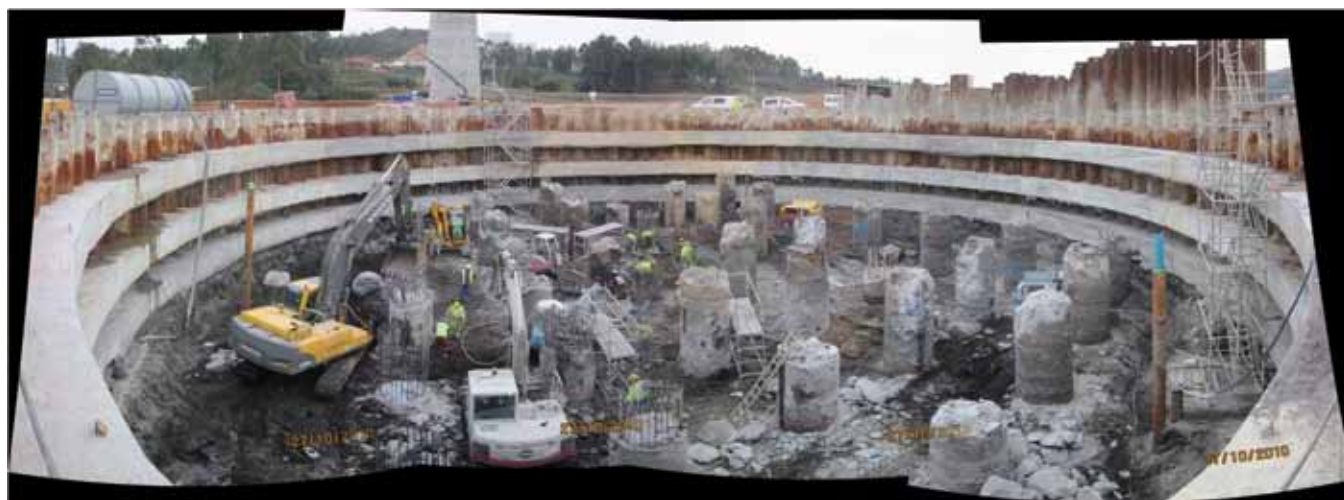
Fig. 5. Descabezado de pilotes del encepado de P-5
