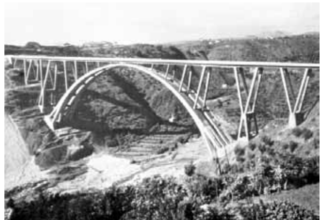
Viaducto del río Fumarella (Italia), Ricardo Morandi. 1962
