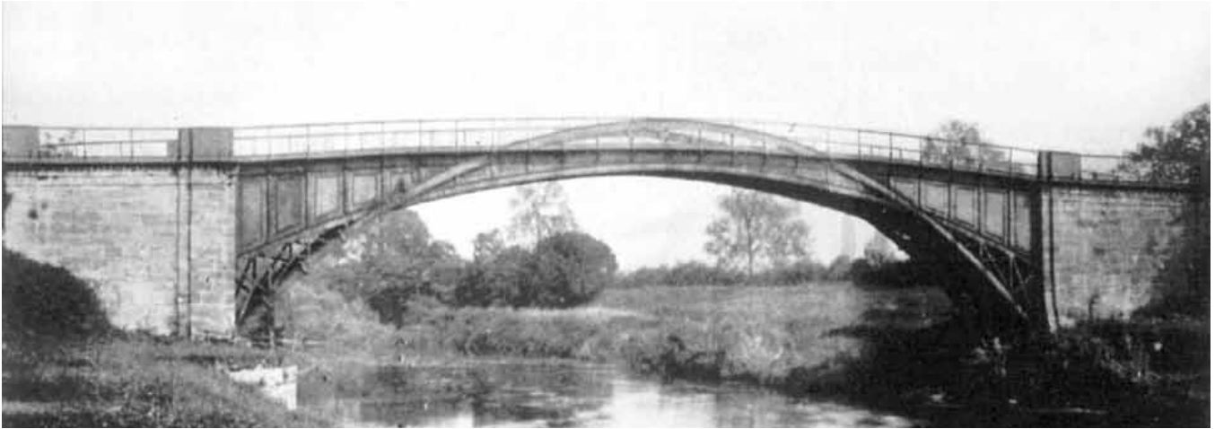
Puente de Buildwas, Thomas Telford. 1796
