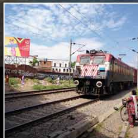
Supervisión del diseño y dirección de obra del ferrocarril de mercancías Bhaupur-Khurja, India
