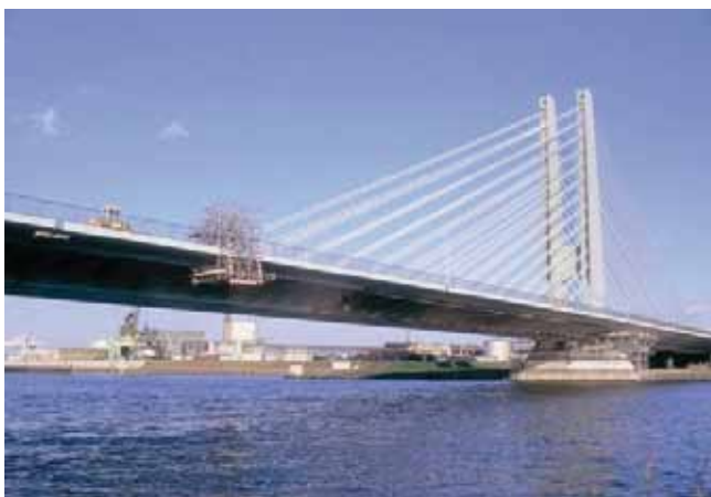
Puente Hoeschst sobre el río Main, Ulrich Finsterwalder. 1972
