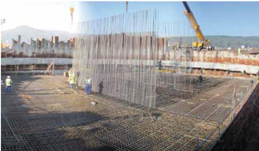
Fig. 6. Vista de la ferralla del encepado de P-5 (30x24,5x4,5m)
