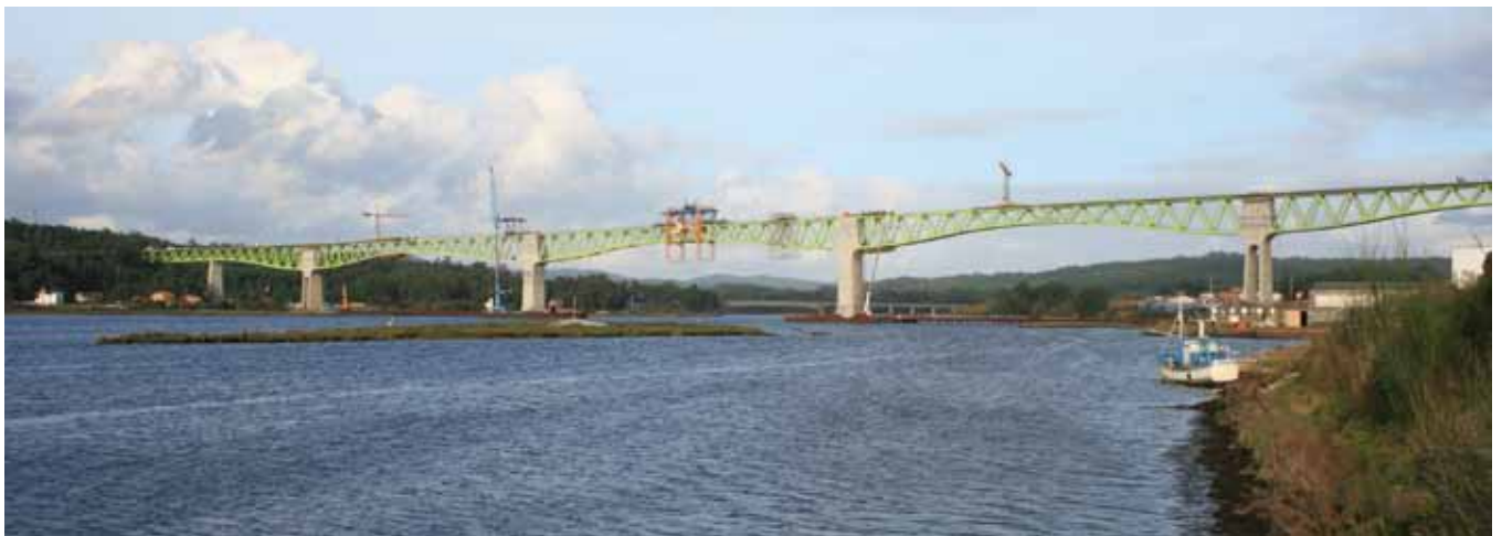
Figs. 1a y 1b. Alzado y vista actual del Viaducto sobre el río Ulla (nov. 2014)
