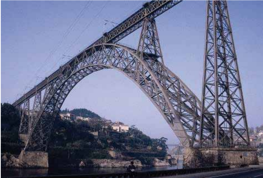
Puente de Maria Pia sobre el río Duero en Oporto, Gustave Eiffel. 1877
