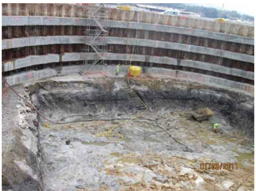
Fig. 7. Vista del fondo rocoso de P-7 previo hormigón de limpieza (27x 24x5,25 m)
