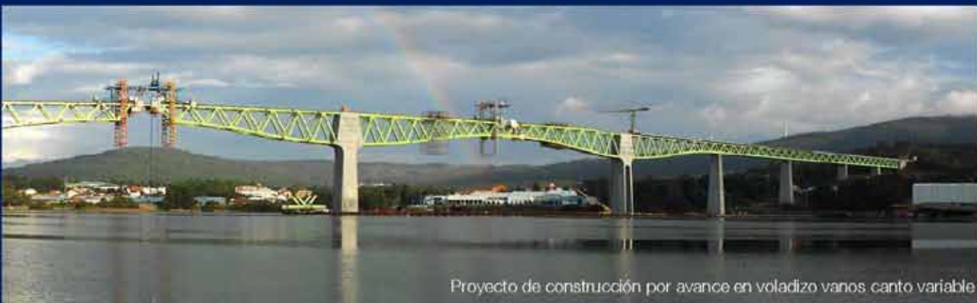
Izado dovelas canto variable
