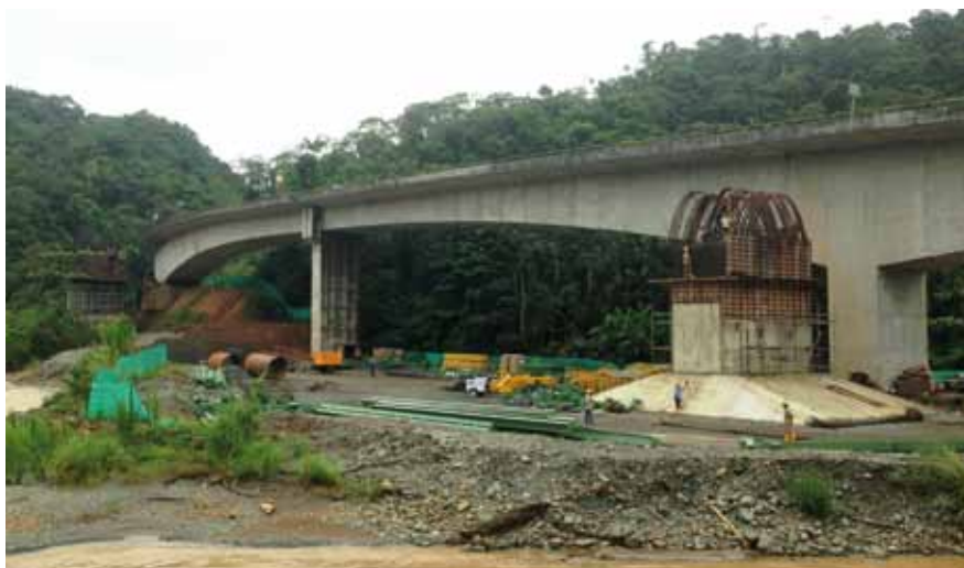
Obras en la carretera de Cali a Buenaventura (Sacyr)
