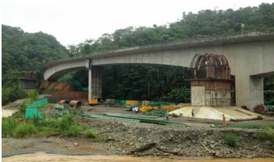
Obras en la carretera de Cali a Buenaventura (Sacyr)
