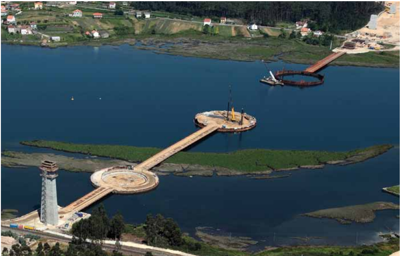
Fig. 3a. Vista aérea de los recintos de las pilas P-5, P-6 y P-7
