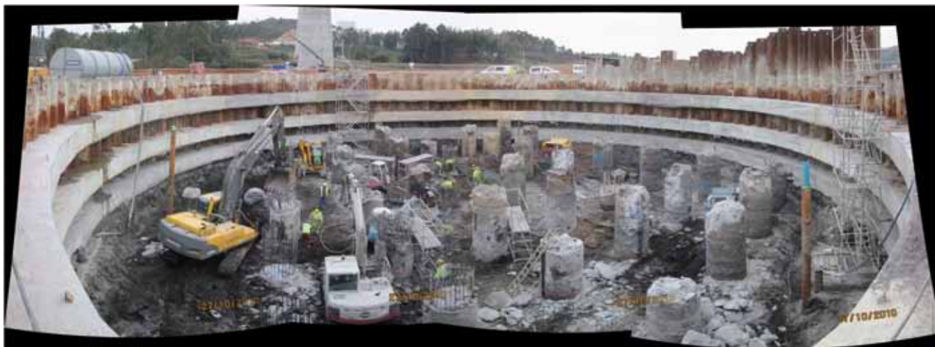
Fig. 5. Descabezado de pilotes del encepado de P-5
