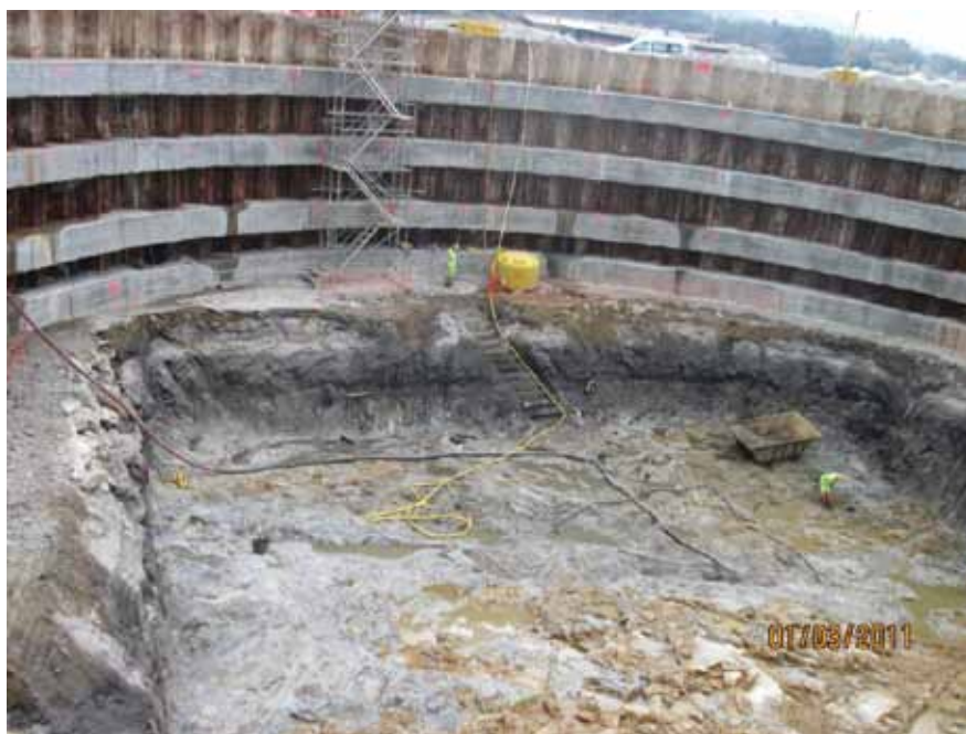
Fig. 7. Vista del fondo rocoso de P-7 previo hormigón de limpieza (27x 24x5,25 m)
