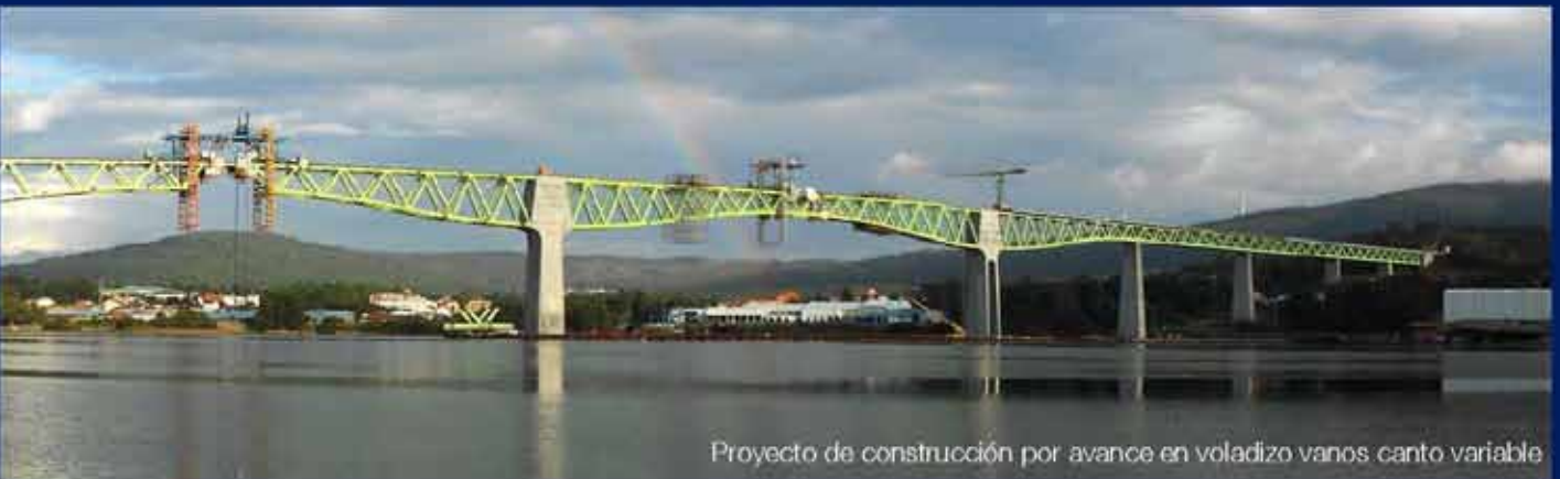
Izado dovelas canto variable
