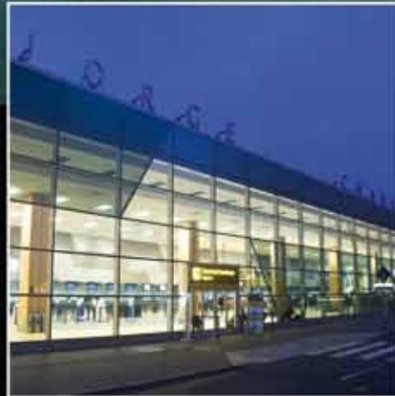
Supervisión de la ampliación del Aeropuerto Internacional Jorge Chávez, Lima
