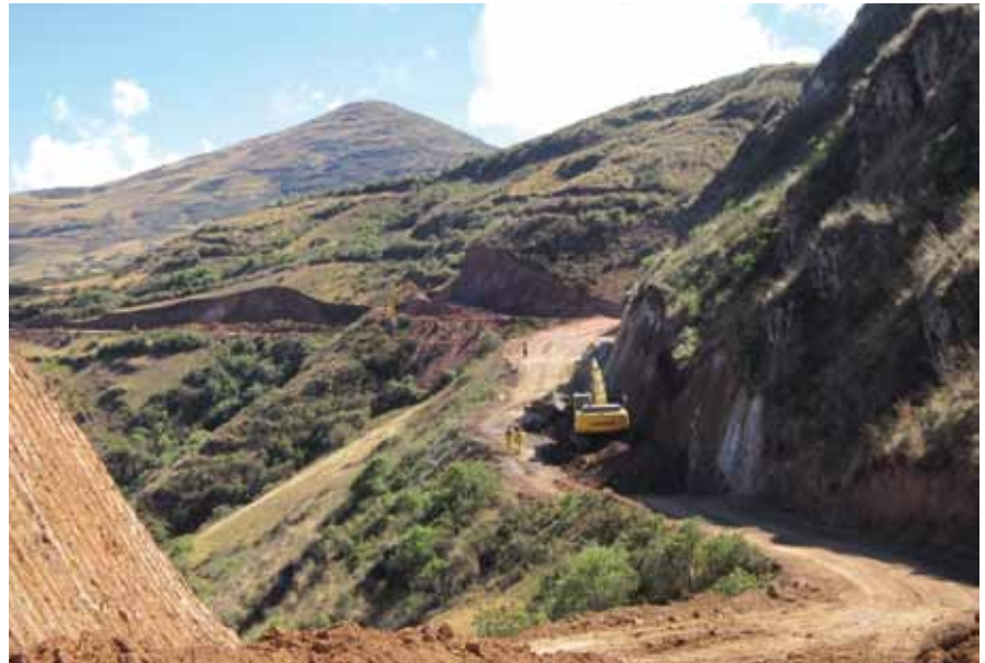
Carretera Ayacucho-Abancay (OHL)
