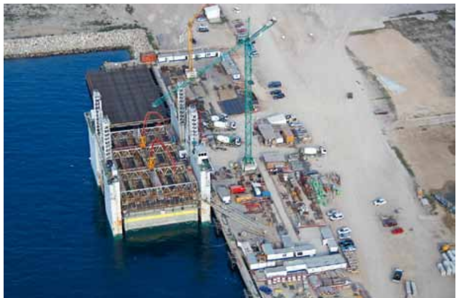
Dique flotante Mar del Aneto (FCC)
