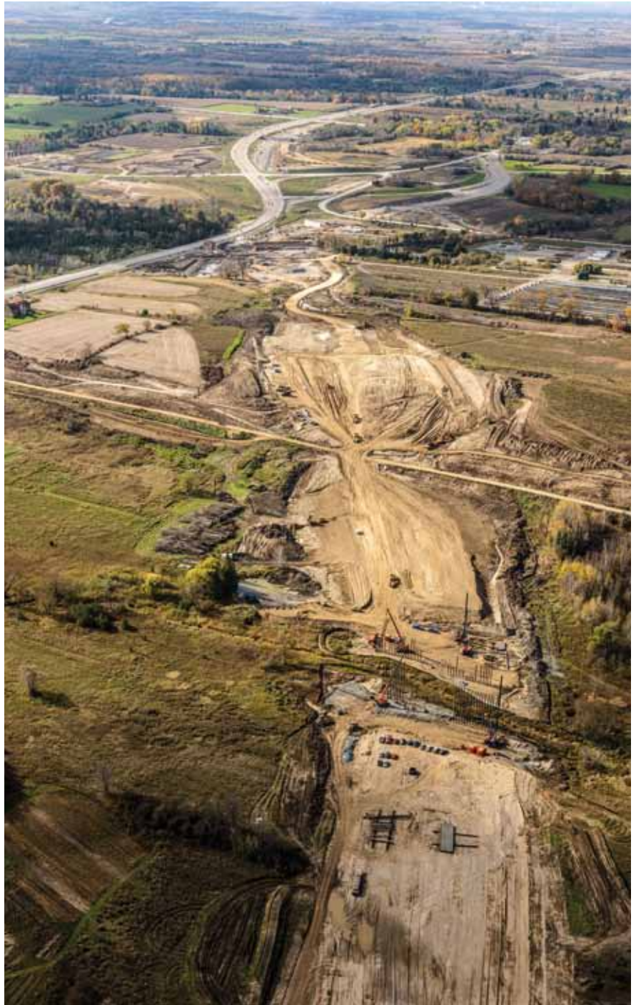
Inicio oeste de la extensión. Fase I
