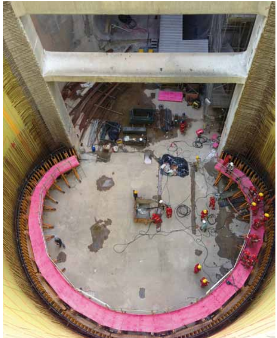
Pozo de acceso en la estación Oscar Freire de la Línea 4 de Metro de São Paulo (Isolux Corsán)
