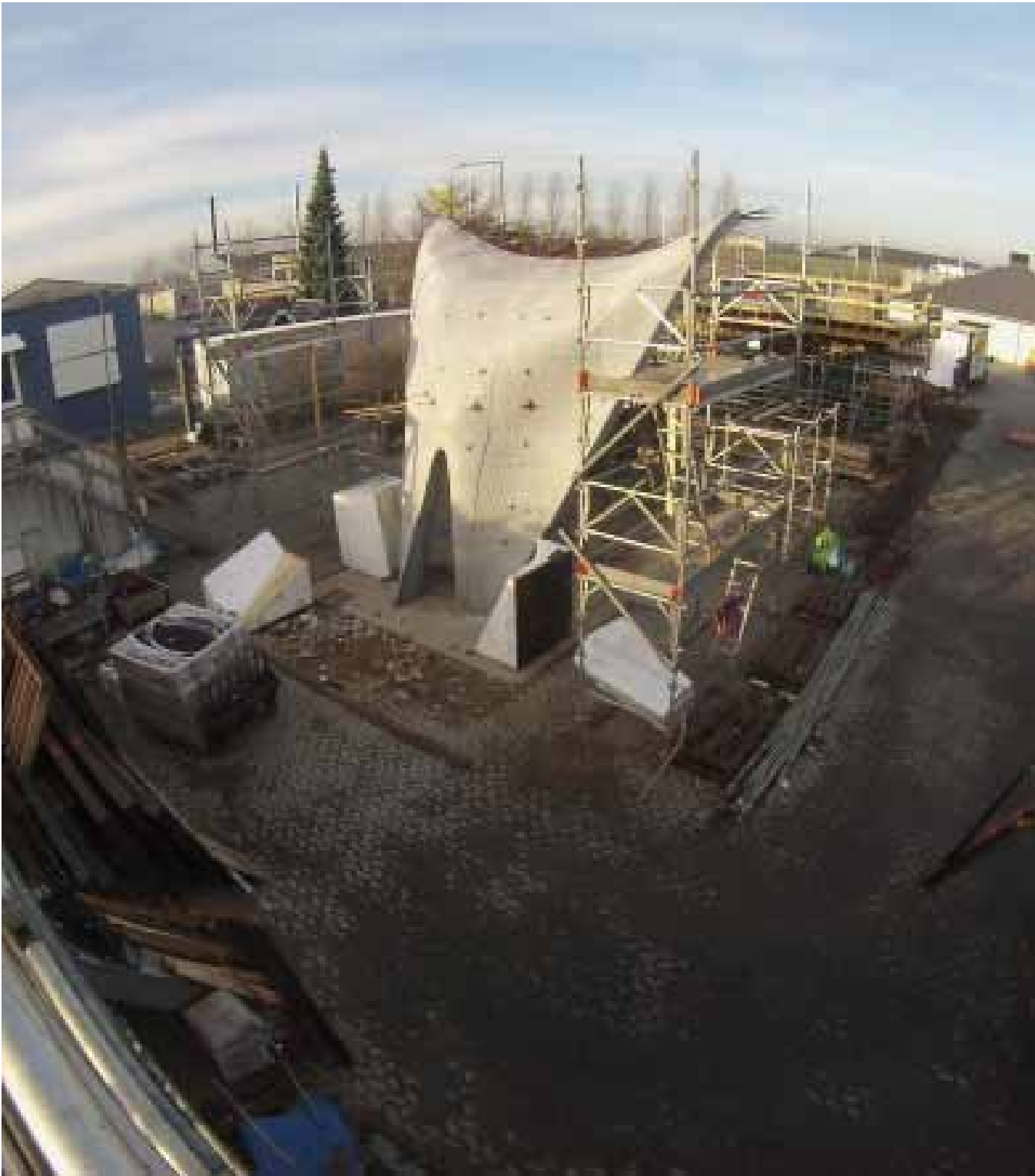
Fig. 2. Ejecución de elemento de doble curvatura con encofrado de poliestireno
