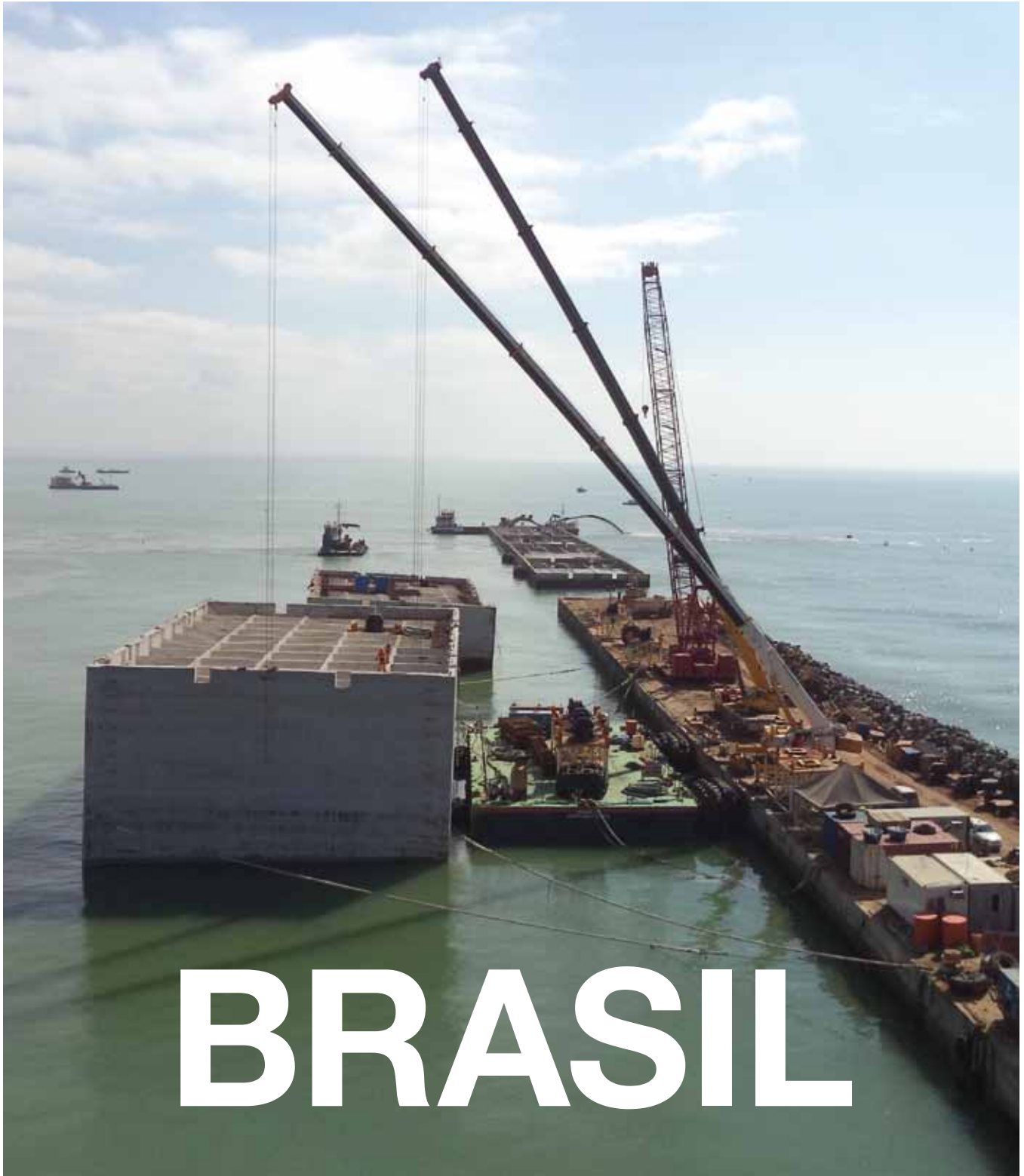
Proceso de colocación de elementos de fondeo sobre un cajón (FCC)
