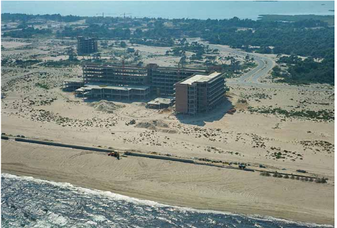
Edificación sobre cordones litorales: Valencia
