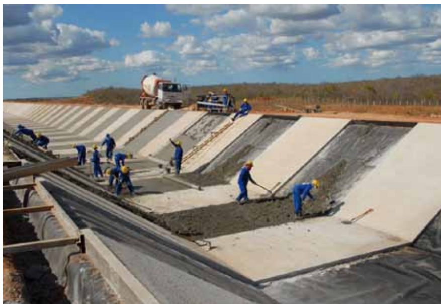
Concesión de abastecimiento de aguas en São Paulo (Sacyr)
