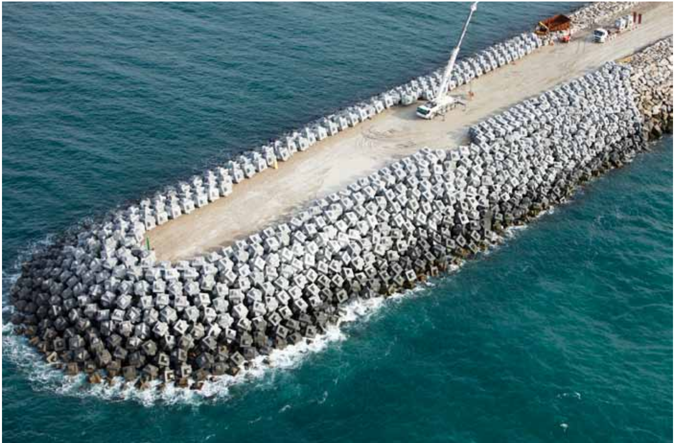
Cubípodos colocados en el Contradique del Puerto Exterior de Punta Langosteira (A Coruña): ejemplo de tecnología ideada en la Universidad (UPV) y desarrollada en colaboración con la empresa (SATO, filial especializada en obras marítimas de OHL)
