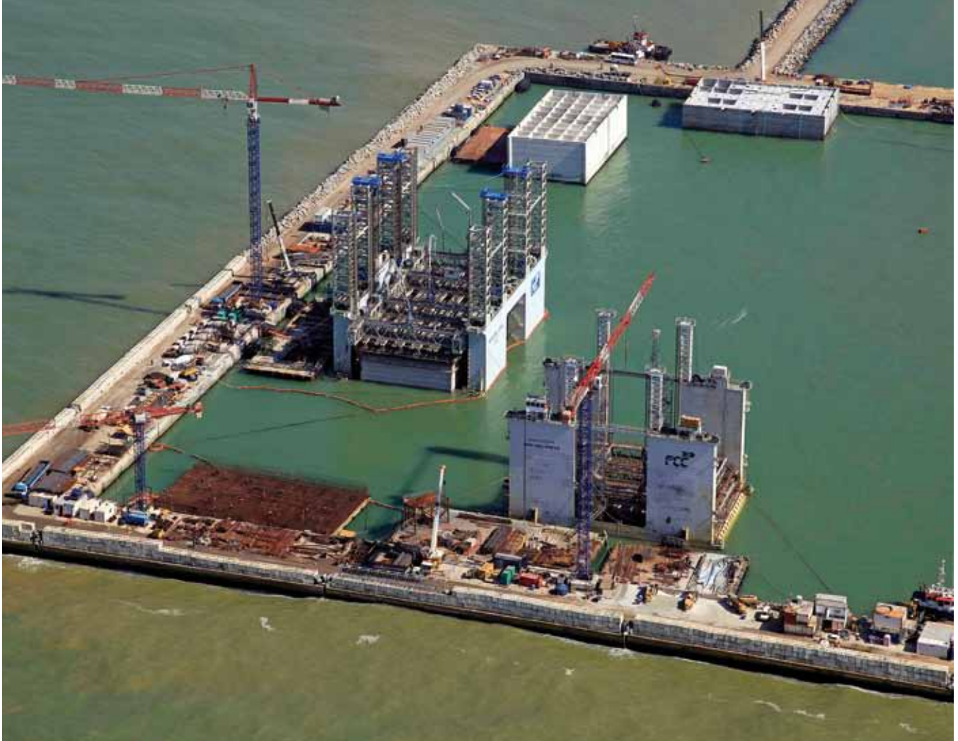
Instalación definitiva de los dos diques flotantes Mar del Aneto y Mar del Enol (FCC)
