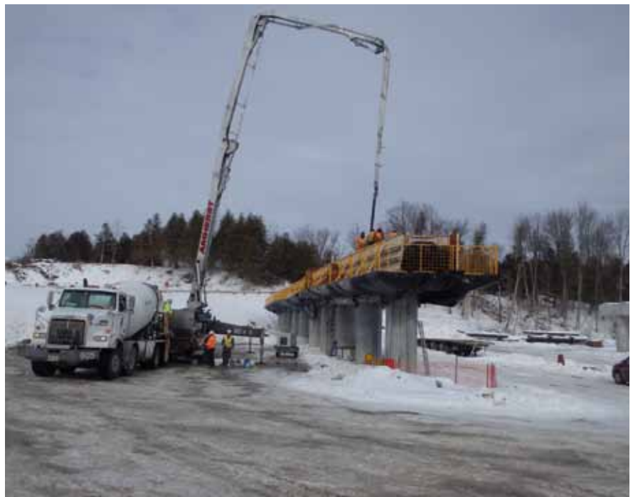
Estructura sobre Duffins Creek
