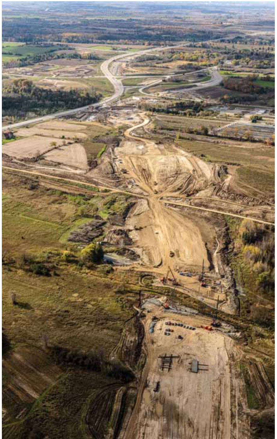
Inicio oeste de la extensión. Fase I
