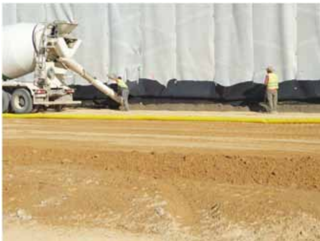
Fig. 1. Hormigonado de la media caña nivelada sobre la que se dispone el tubo dren
