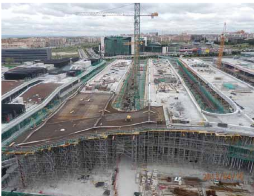
Cimbra aportada para ejecución de fingers y zona sur de plaza
