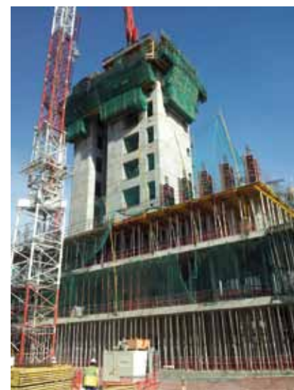
Sistema de encofrado autotrepante sur
