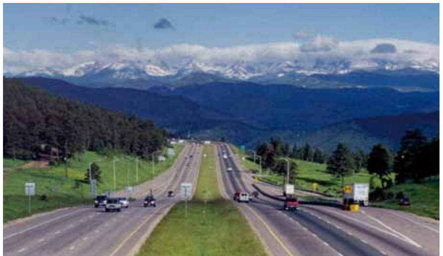
Corredor de la I-75 (Typsa)
