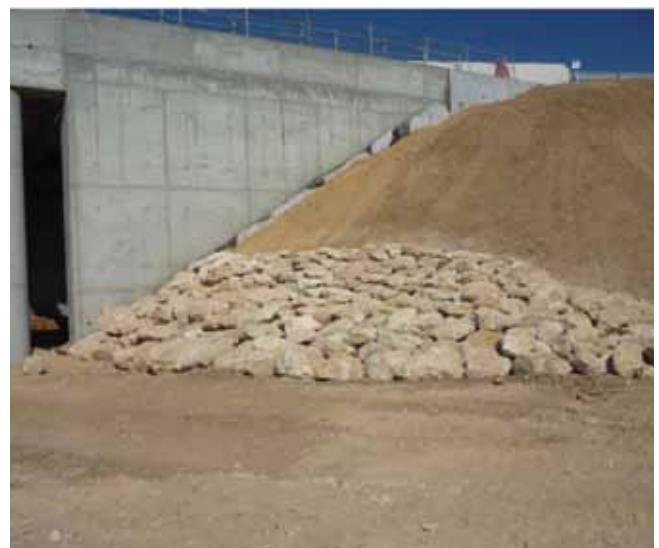
Fig. 6. Escollera de protección en el pie del cono de tierras que se forma en el trasdós
