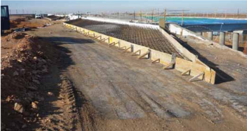
Fig. 5. Ejecución de las losas de transición del trasdós sobre el metro de suelo cemento (en la fotografía se puede observar el riego de curado que se aplicó al suelo cemento)
