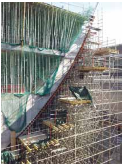
Cimbra-encofrado para ejecución anillo exterior, zona este
