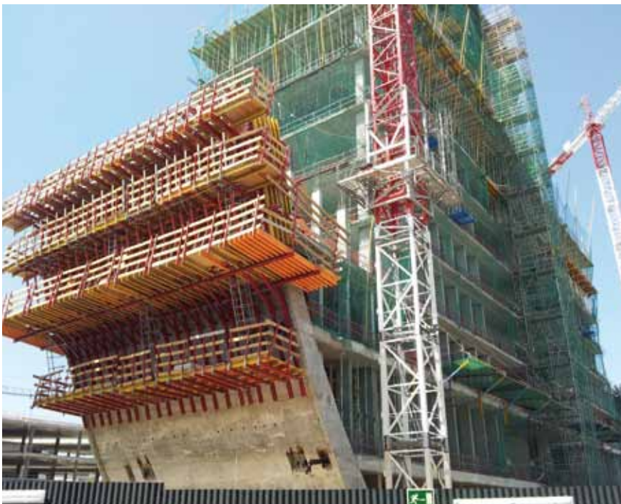
Encofrado autotrepante núcleo y cimbra cuajada para primeros tramos de muro curvo
