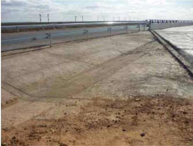
Fig. 7. Hormigonado por completo de la mediana en el trasdós
