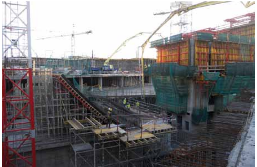
Encofrado autotrepante núcleo y cimbra cuajada para primeros tramos de muro curvo
