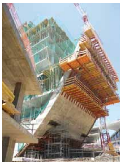
Encofrado trepante una vez superada fase sobre cimbra
