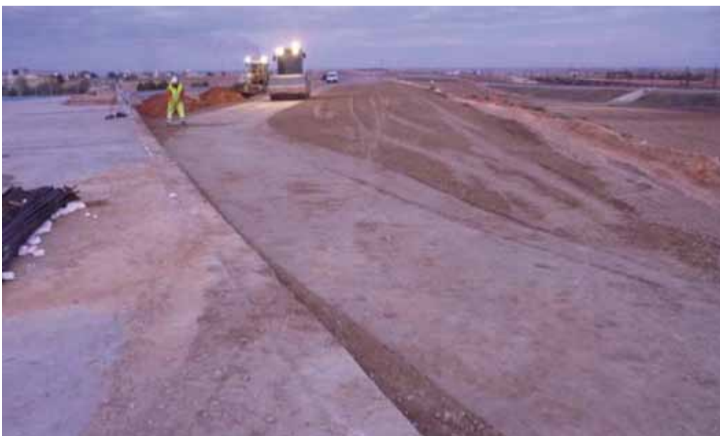
Fig. 4. Ejecución de la última tongada del metro de suelo cemento
