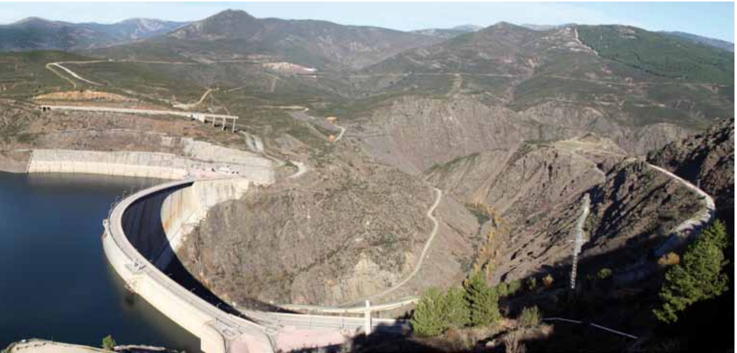
La Presa del Atazar, pieza clave en el abastecimiento de agua a la ciudad de Madrid, finalizada en 1972, y que con 42 años en explotación está en el entorno de la edad media del parque español de presas (45 años).
