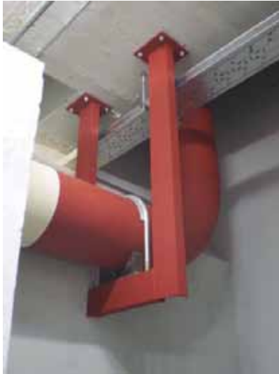
Fig. 5. Sujeción de tubería
