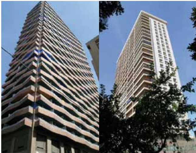
Fig. 8. Edificios de Muñoz y Solera
