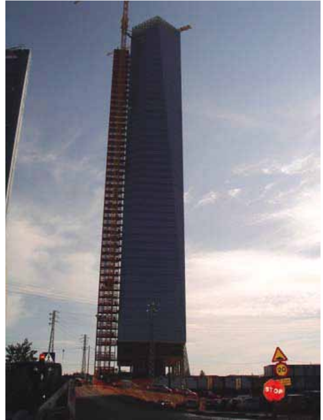
Fig. 10. Grúa y montacargas en Torre Cristal, Madrid
