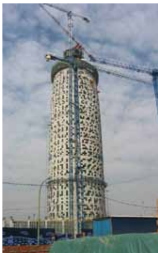
Fig. 15. Sistema de protección perimetral para las Torres Garellano en Bilbao. Fig. 16. Detalle de la protección perimetral en las Torres Garellano. Fig. 17. Sistema de protección perimetral en Torre PwC
