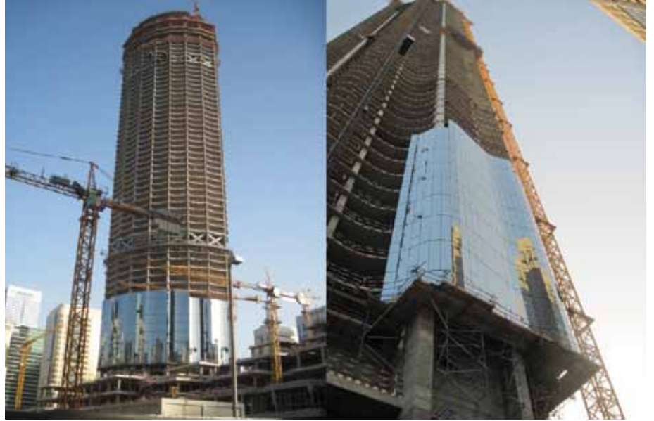
Instalación de muros cortina modulares. Central Market Redevelopment (Abu Dhabi)
