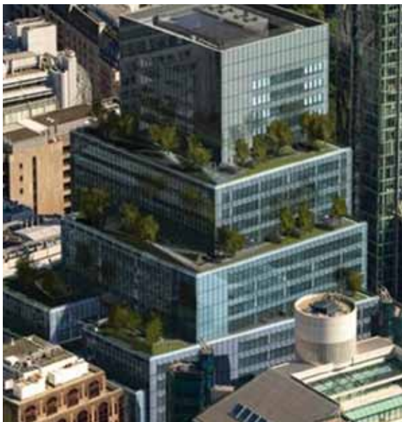
Ropemaker Place (Londres). Edificio galardonado con BREEM Excellent y LEED Platinum pre-certification
