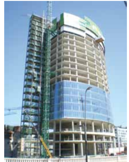
Fig. 28. Torre de ascensores en Torre Cristal. Fig. 29. Detalle de la Torre de ascensores de Torre Cristal Fig. 30. Torres de ascensores en Torre Iberdrola
