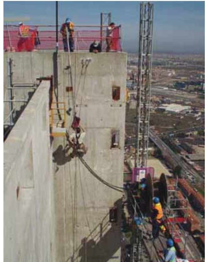
Fig. 6. Montaje de cableado eléctrico en patio vertical desde el exterior
