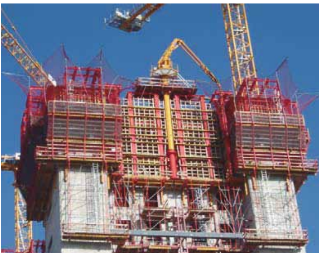
Fig. 9. Encófrados autotrepantes en Edificio Caja Madrid
