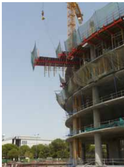
Fig. 22. Mesa de grandes dimensiones utilizada en Torre Isla Cartuja. Fig. 23. Extracción de una mesa en Torre Isla Cartuja.
