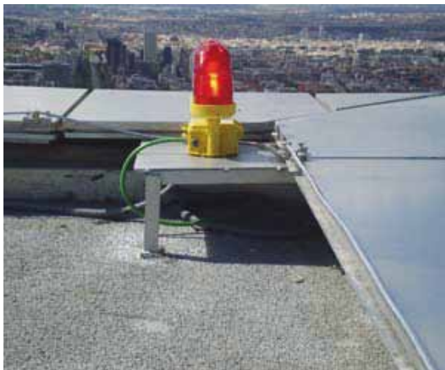
Fig. 7. Señalización de balizamiento en cubierta
