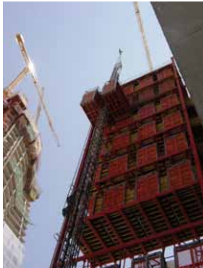
Fig. 28. Torre de ascensores en Torre Cristal. Fig. 29. Detalle de la Torre de ascensores de Torre Cristal Fig. 30. Torres de ascensores en Torre Iberdrola
