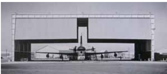
Fig. 16. Hangar San Francisco 1956 Myron Goldsmith
