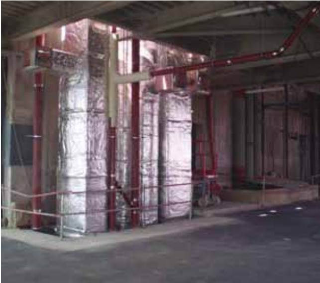
Fig. 3. Patio vertical de instalaciones
