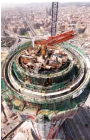
Fig. 12. Distribuidor de hormigón en Torre Agbar. Fig.13. Sistema de polipastos instalados en las plataformas autotrepantes de Torre Cristal. Fig. 14. Distribuidor de hormigón en las Torres Fira Barcelona
