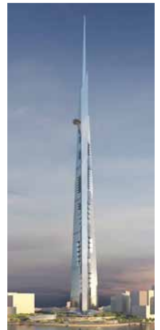
Kingdom Tower, Jeddah (en construcción, >1000m)
