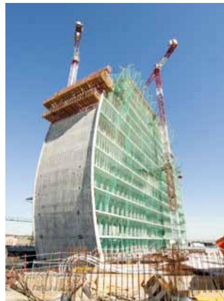
Fig. 28. Torre de ascensores en Torre Cristal. Fig. 29. Detalle de la Torre de ascensores de Torre Cristal Fig. 30. Torres de ascensores en Torre Iberdrola
