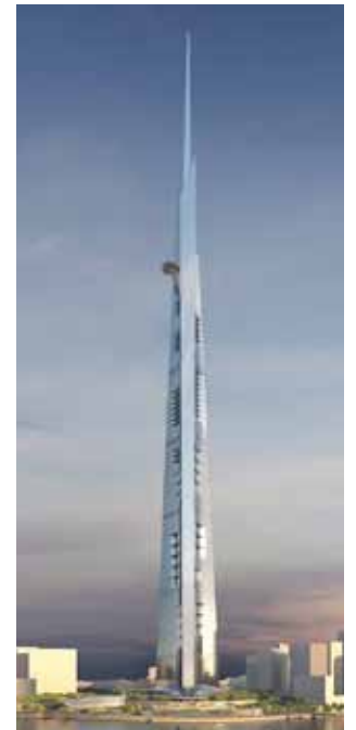
Kingdom Tower, Jeddah (en construcción, >1000m)
