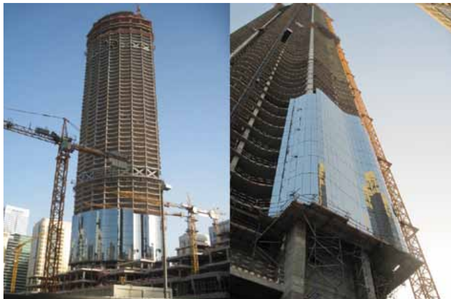
Instalación de muros cortina modulares. Central Market Redevelopment (Abu Dhabi)
