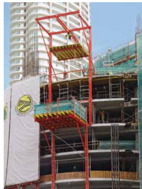
Fig. 27. Izado de una mesa de forjado mediante polipasto instalado en una plataforma volada
