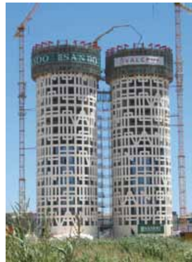
Fig. 15. Sistema de protección perimetral para las Torres Garellano en Bilbao. Fig. 16. Detalle de la protección perimetral en las Torres Garellano. Fig. 17. Sistema de protección perimetral en Torre PwC
