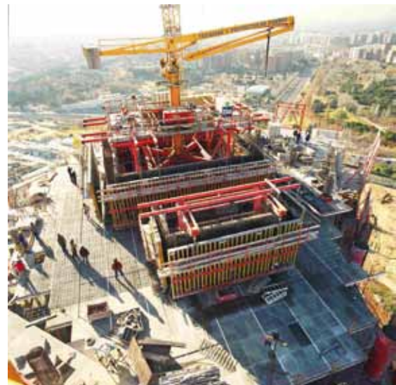
Fig. 7. Ejecución monolítica de forjados y Núcleos en Torre Espacio. Sistema Plataforma
