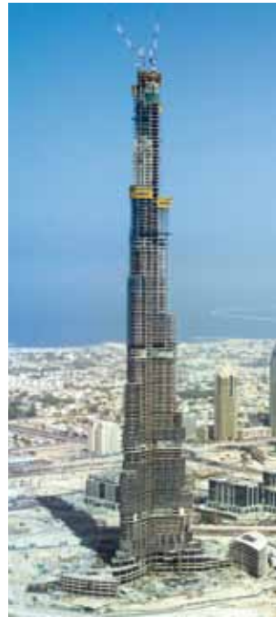
Fig. 1. Construcción del edificio Burj Khalifa
