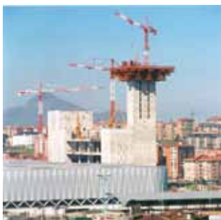
Fig. 25. BEC. Montajes de los encofrados de las vigas del HAT, con la cimbra posicionada en coronación de la torre
