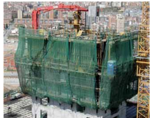
Fig. 12. Distribuidor de hormigón en Torre Agbar. Fig.13. Sistema de polipastos instalados en las plataformas autotrepantes de Torre Cristal. Fig. 14. Distribuidor de hormigón en las Torres Fira Barcelona
