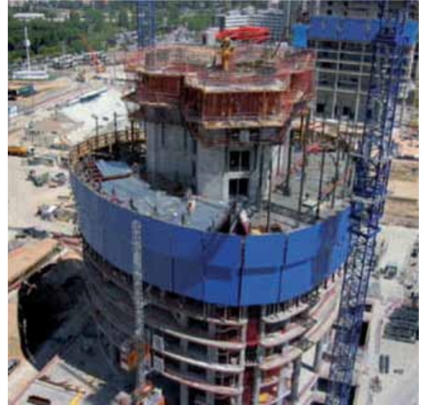
Fig. 9. Ejecución de Torre PwC con los núcleos en avance respecto a los forjados. Combinación de sistemas Regular y Plataformas
