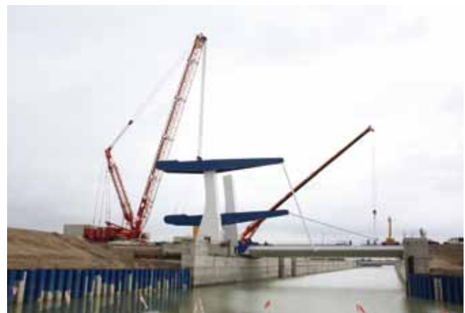
Montaje del contrapeso del puente. Diciembre de 2009
