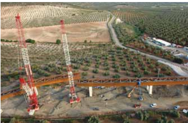
Figs. 16a y 16b. Izado de dovelas metálicas mediante grúa
