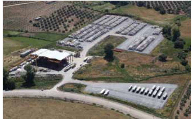
Planta de fabricación de dovelas
