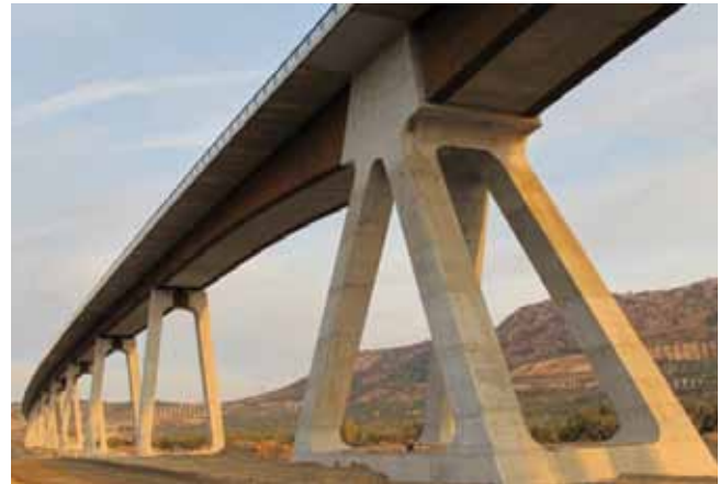
Figs. 3a y 3b. Punto fijo del tablero en la Pila Central
