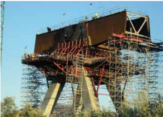
Figs. 12a y 12b. Ejecución de los cuatro fustes y de la cabeza de la Pila Central del viaducto
