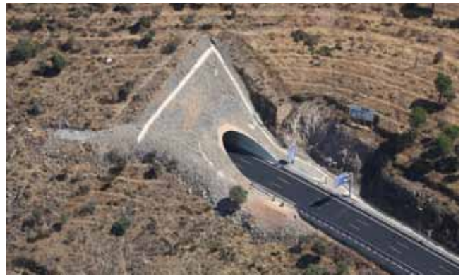
Boca sur Túnel del Corzo
