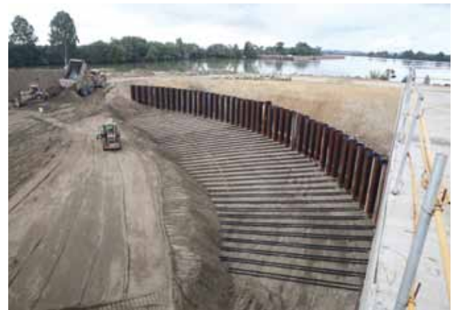
Anclajes tablestacas. Octubre de 2009
