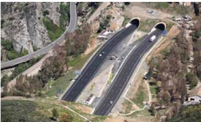
Boca sur Túnel de Despeñaperros
