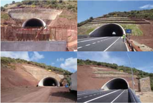
Emboquillados del túnel antes y después de la restitución topográfica
