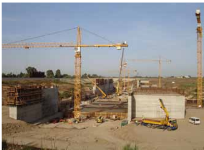
Estructura. Julio de 2008
