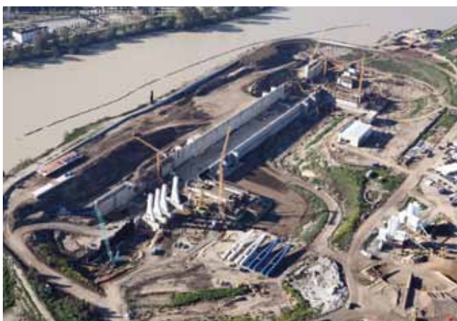
Estructura. Enero de 2009
