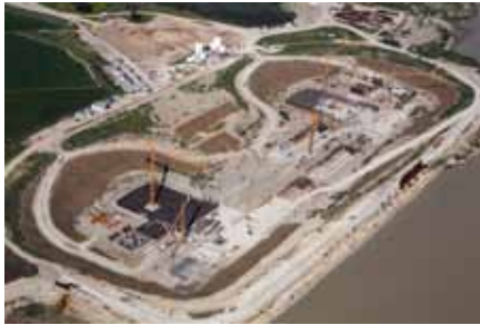
Estructura. Febrero de 2008
