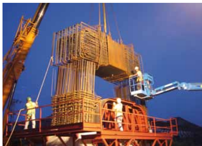
Figs. 10a y 10b. Ejecución de los alzados de las pilas mediante encofrado trepante y montaje de la ferralla prefabricada del dintel
