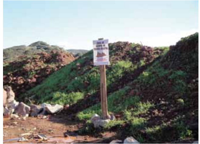
Acopio señalizado de tierra vegetal
