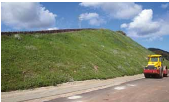
Desmonte tratado con hidromanta
