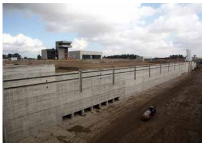
Estructura terminada. Octubre de 2009
