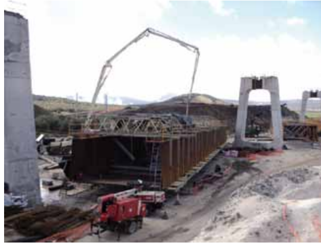
Figs. 15a y 15b. Acopio en obra de dovelas metálicas y ejecución de hormigón de fondo previamente al izado
