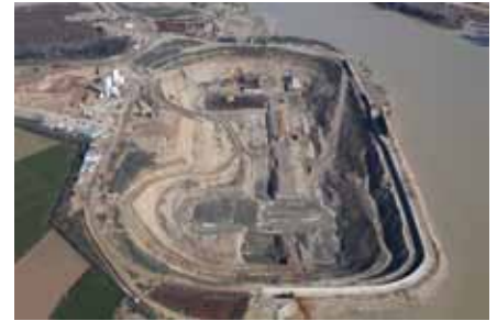
Estructura. Diciembre de 2007
