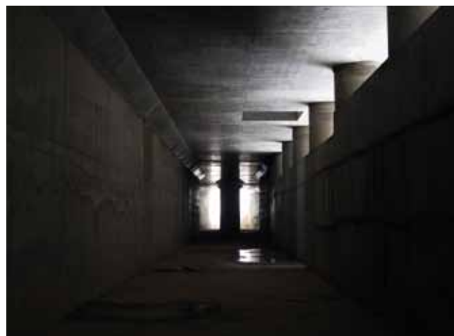
Interior de canales de llenado y vaciado. Octubre de 2009
