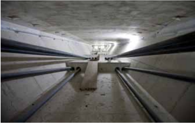
Interior del tablero
