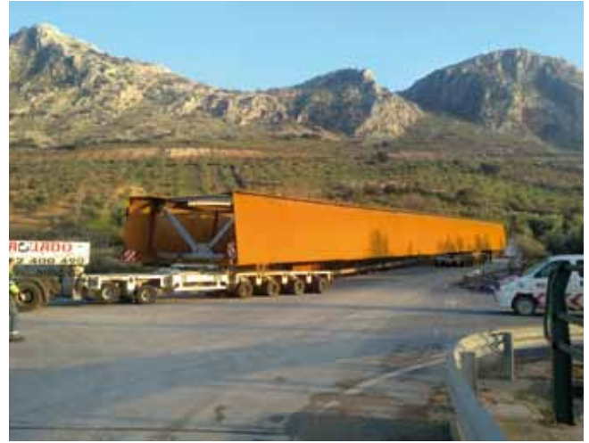
Figs. 14a y 14b. Fabricación en taller y transporte a obra de dovelas metálicas del tablero
