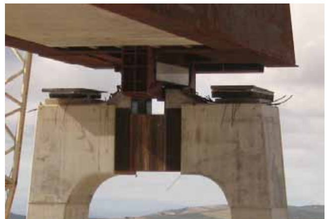
Figs. 17a y 17b. Detalle de punto fijo provisional durante el montaje y aparatos de apoyo en cabeza de pila
