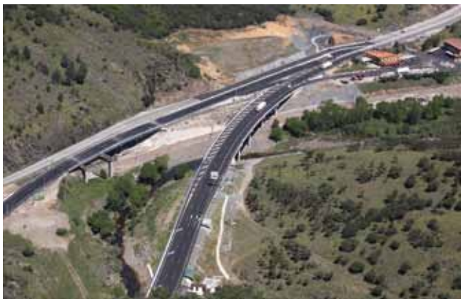
Viaducto de Venta de Cárdenas y conexión final
