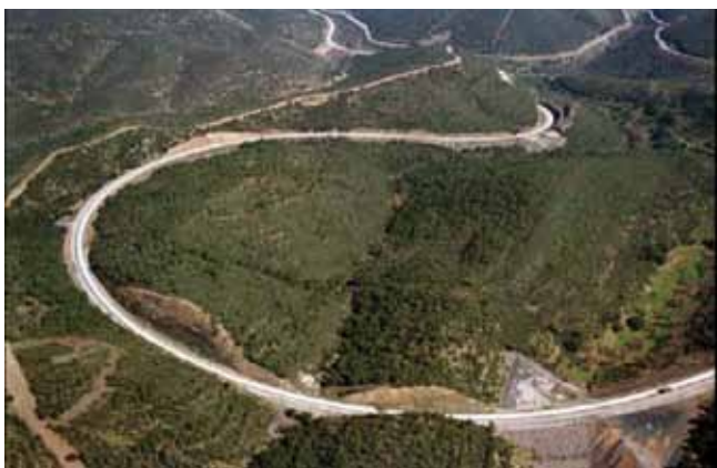
Antigua calzada sur p.k. 252,3-p.k. 256,7
