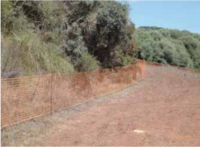
Balizamiento de obra con malla naranja
