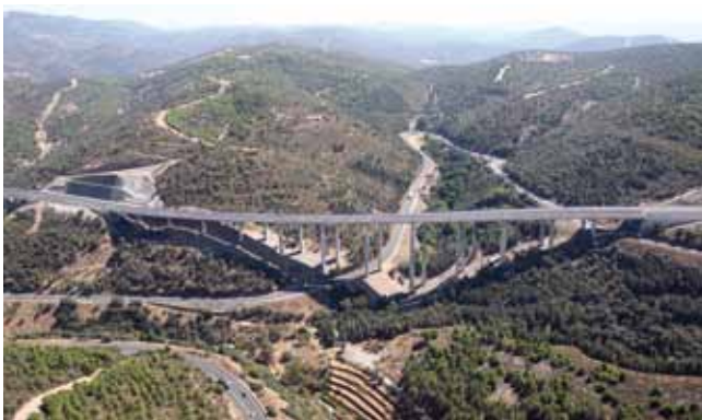
Viaducto de El Manantial
