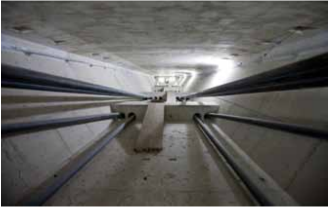
Interior del tablero
