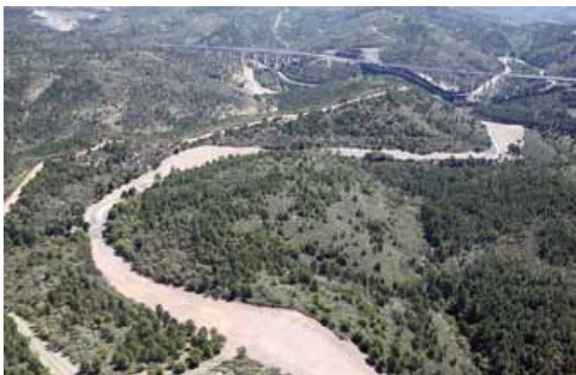
Restauración calzada sur p.k. 252,3-p.k. 256,7
