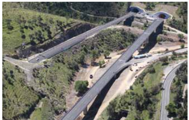
Viaducto del corzo sur y bocas Túnel de Despeñaperros
