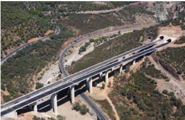
Viaducto de Despeñaperros y boca sur Túnel de Cantera
