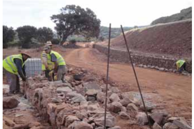
Construcción muro de pared seca
