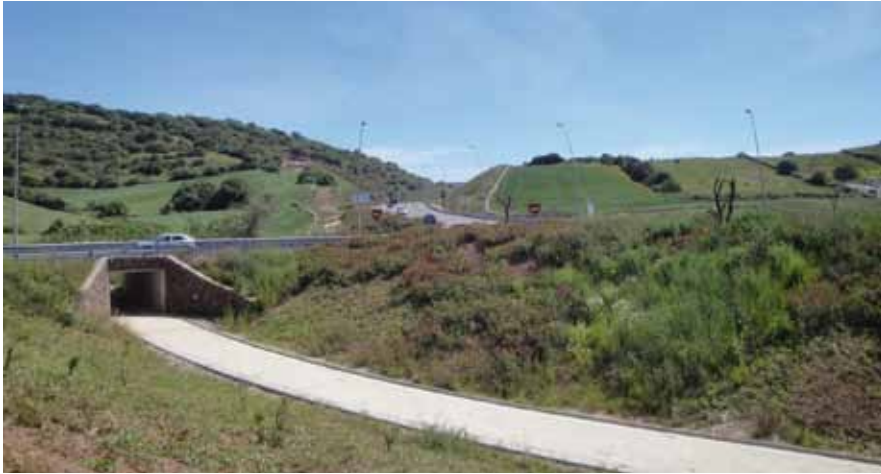
Tratamiento paisajístico del paso inferior de Cala Galdana
