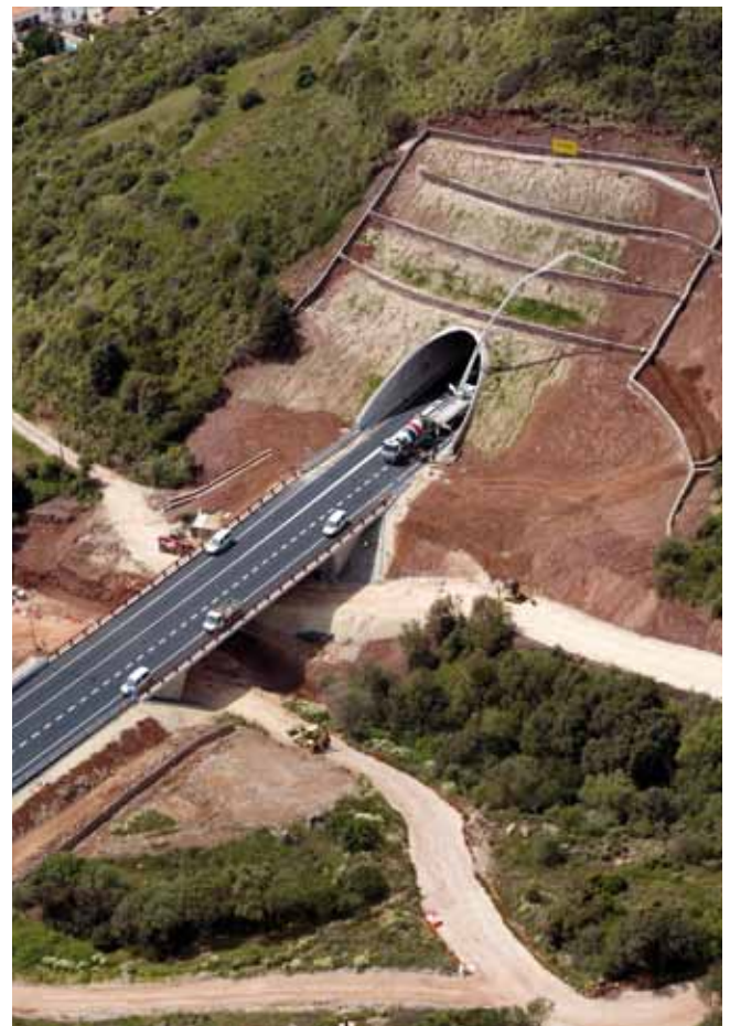
Emboquillado del túnel y estructura del p.k. 0+700 en el tramo 2
