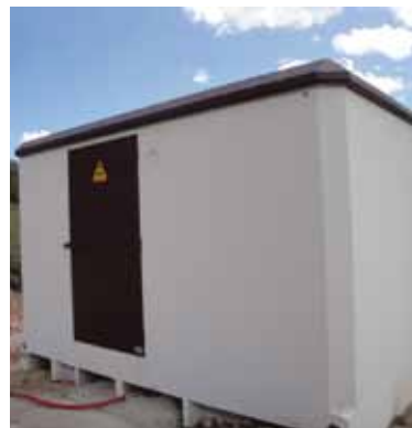
Bouer reconstruido con un CT en su interior
