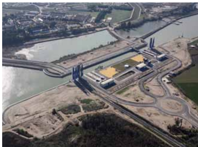
Vista general. Noviembre de 2011
