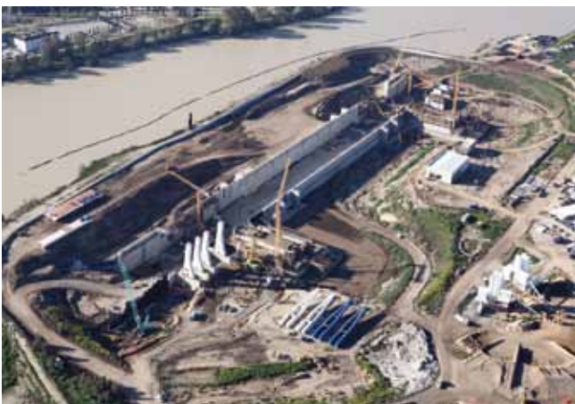
Estructura. Enero de 2009
