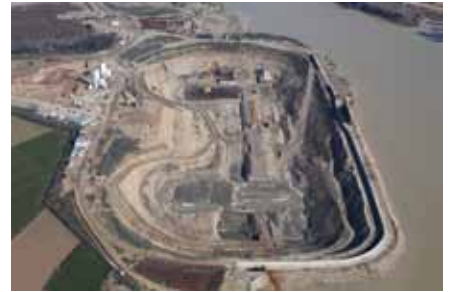
Estructura. Diciembre de 2007
