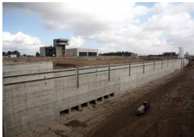
Estructura terminada. Octubre de 2009
