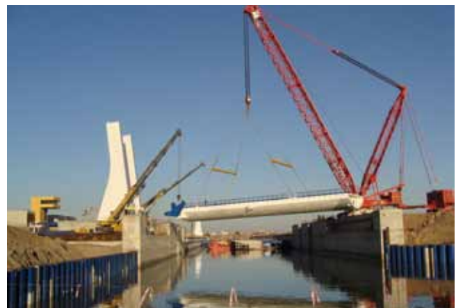
Montaje de un tablero puente. Noviembre de 2009
