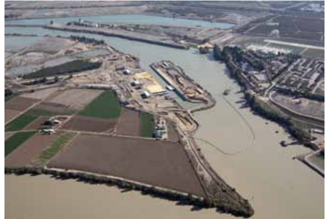
Vista general. Noviembre de 2009
