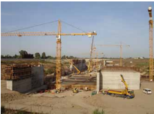
Estructura. Julio de 2008
