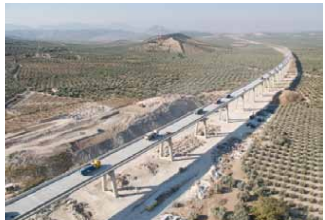
Figs. 20a y 20b. Vista de la ejecución de los acabados y prueba de carga estática del tablero
