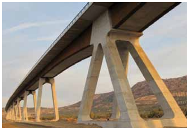
Figs. 3a y 3b. Punto fijo del tablero en la Pila Central
