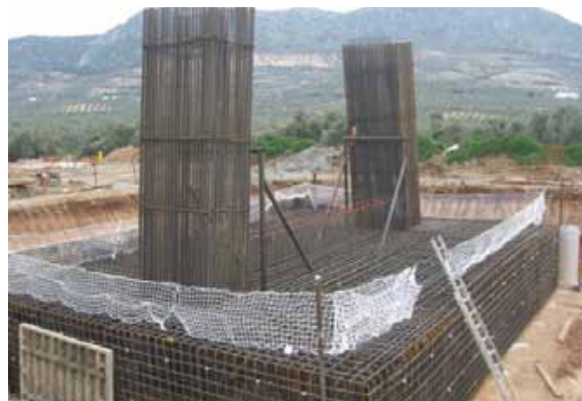
Figs. 8a y 8b. Montaje de la ferralla de los encepados de las pilas tipo
