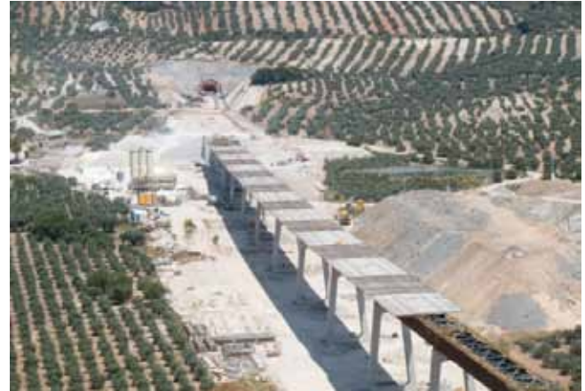
Figs. 19a y 19b. Losa prefabricada de ancho completo y vista general del montaje de prelosas
