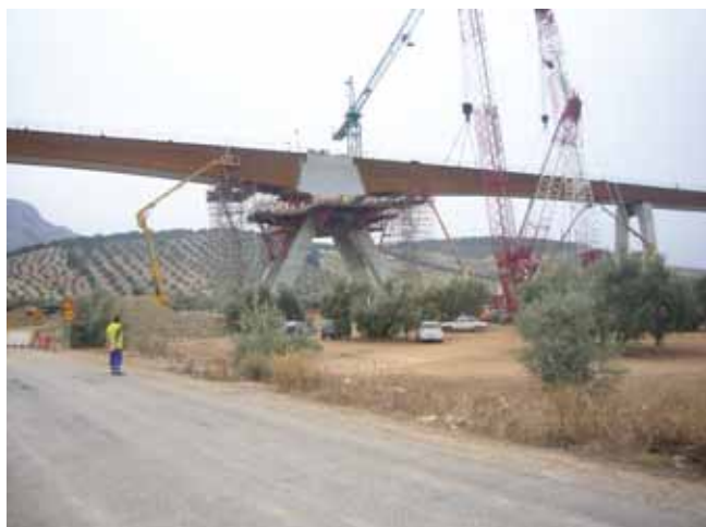
Figs. 18a y 18b. Vista durante el montaje de vanos y colocación de tramo de cierre
