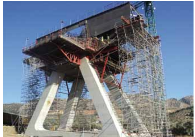
Figs. 13a y 13b. Detalle de la conexión del tablero metálico con la cabeza de la Pila Central
