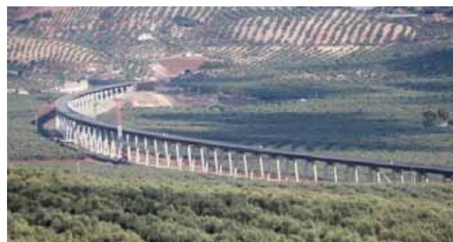
Figs. 2a y 2b. Ajuste de la rasante de la línea por afección al acuífero. Túnel y Viaducto de Archidona
