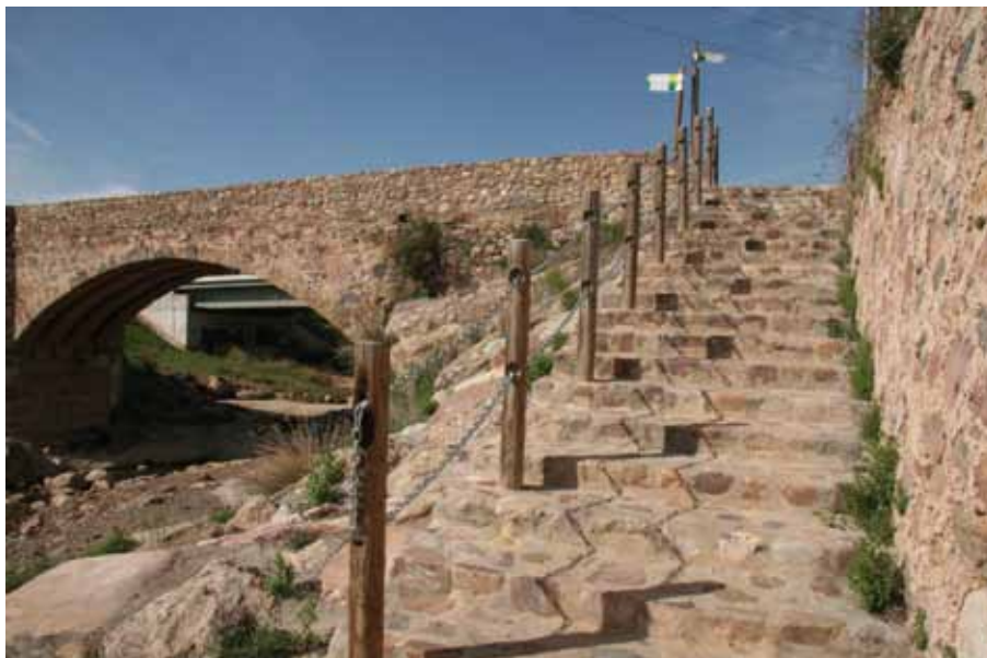
Fig. 9. Puente de Onda sobre el río Seco en Betxi (Castellón). Cortesía Fundación Miguel Aguiló
