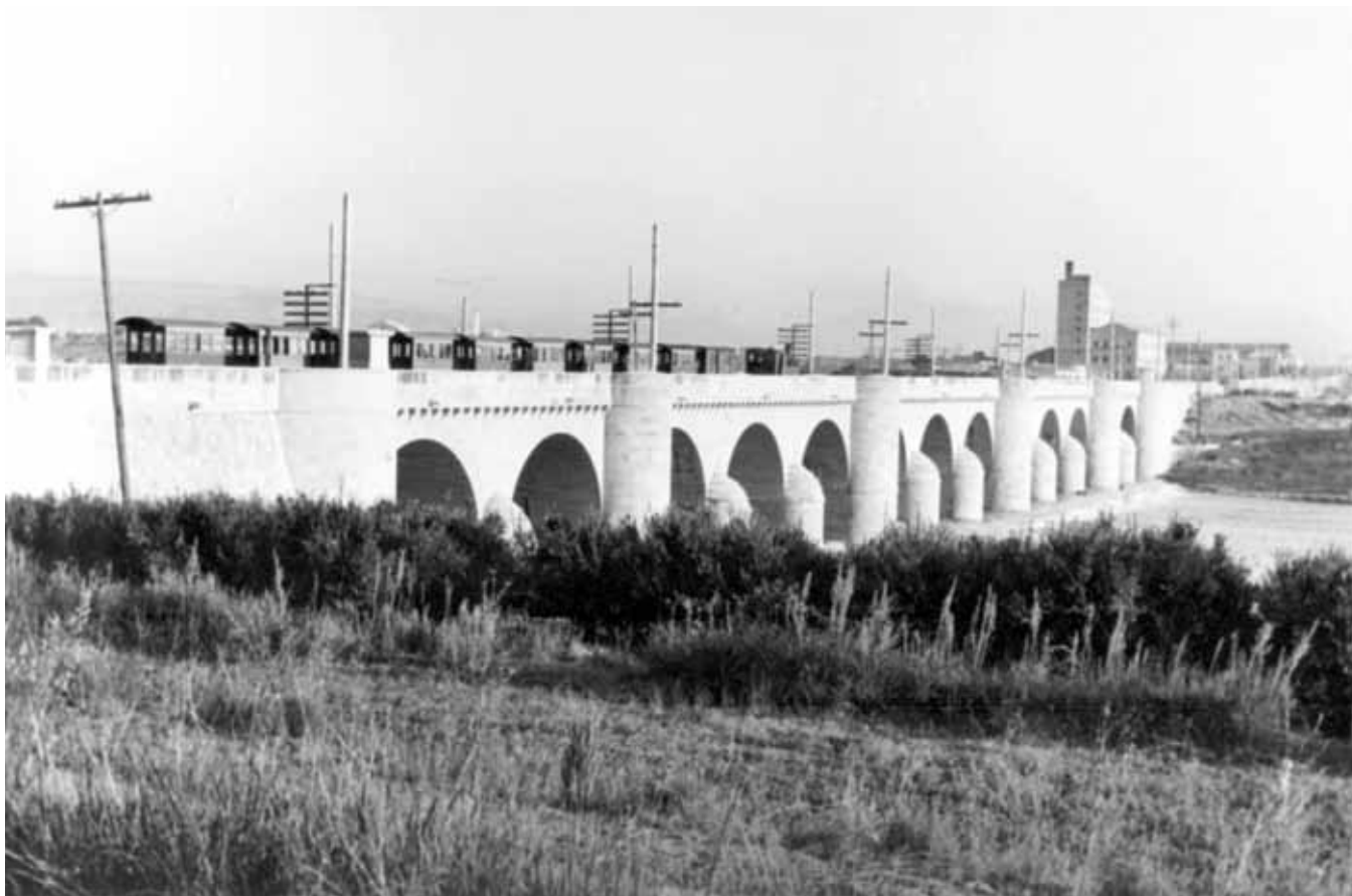
Fig. 7. Puente sobre el río Mijares en Villarreal (Castellón). Ampliación de la calzada (1952-1955). Cortesía de J. Huguet
