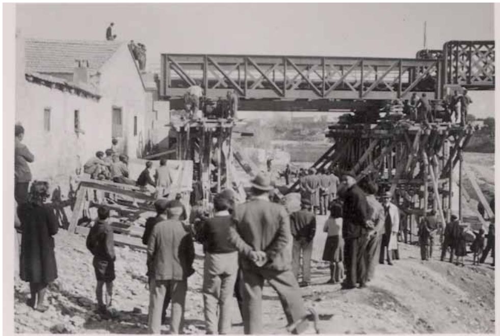
Fig. 3. Sustitución de tramo metálico en el puente sobre el río Seco en la línea A.V.T., (Castellón), ca. 1915. Biblioteca-Arxiu de la Diputació Provincial de Castelló
