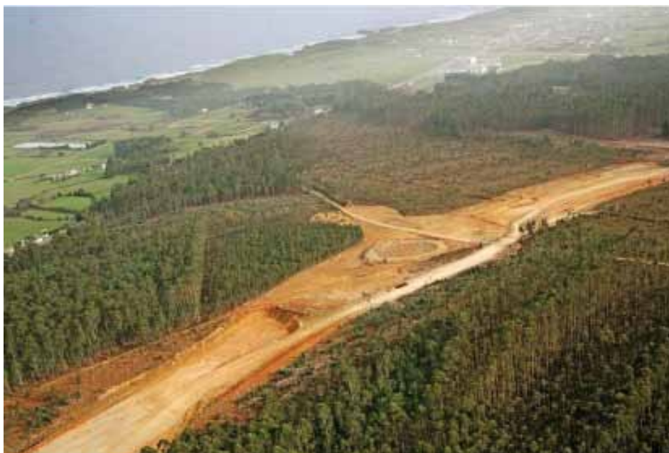
Fig. 6. Explanación de la Autovía del Cantábrico (A-8) en Barreiros (Lugo), con el eje afectando al Castro de Roda. Jefatura Regional de Carreteras del Estado en Galicia
