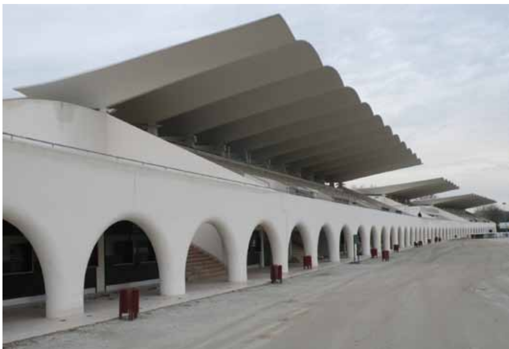
Fig. 10. Cubierta del Hipódromo de la Zarzuela (1935) de Eduardo Torroja. Foto: C. Nárdiz
