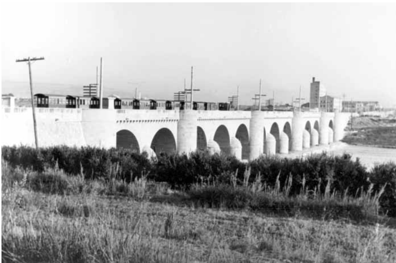
Fig. 7. Puente sobre el río Mijares en Villarreal (Castellón). Ampliación de la calzada (1952-1955). Cortesía de J. Huguet
